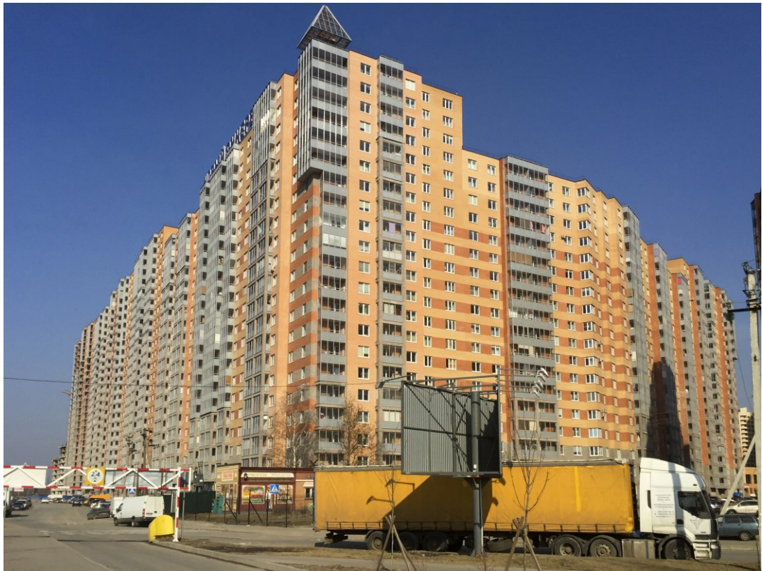
Вид с Областной улицы на секции (слева направо) 17-7
