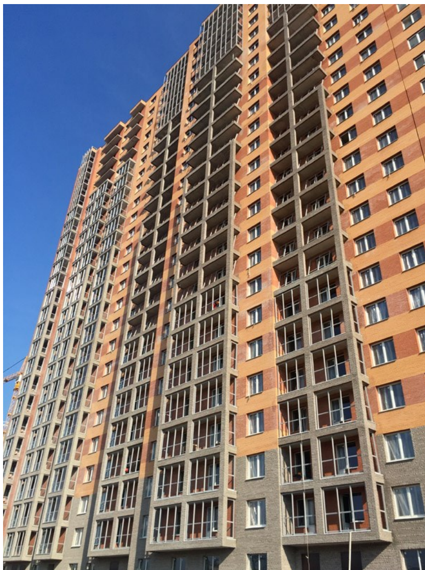
Вид со стороны Областной ул., секции 15-17 29.03.2016 ПУСКИ 1, 2, 3 (СДАНЫ)
