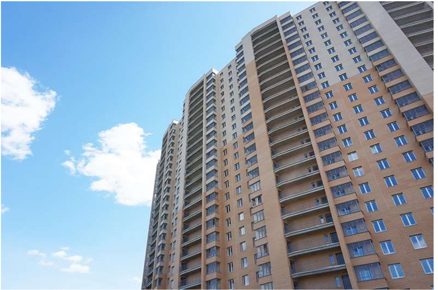
Вид на секции 8-5 с Областной ул.
