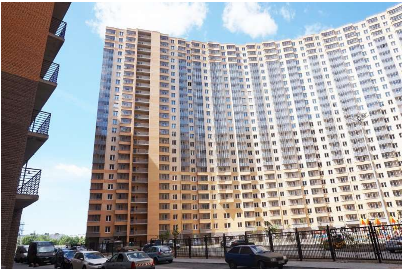
Вид на секции 1-4 со двора
