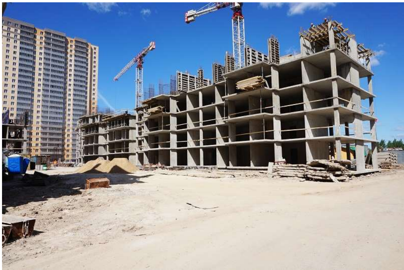
Вид на корпус 1 секции 4-6 со стороны Каштановой ул.
