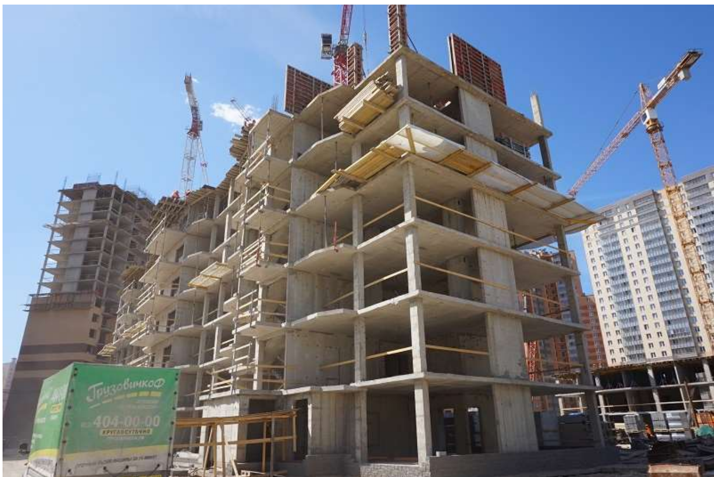
Вид на корпус 5 секции 13-12 со стороны Каштановой ал.
