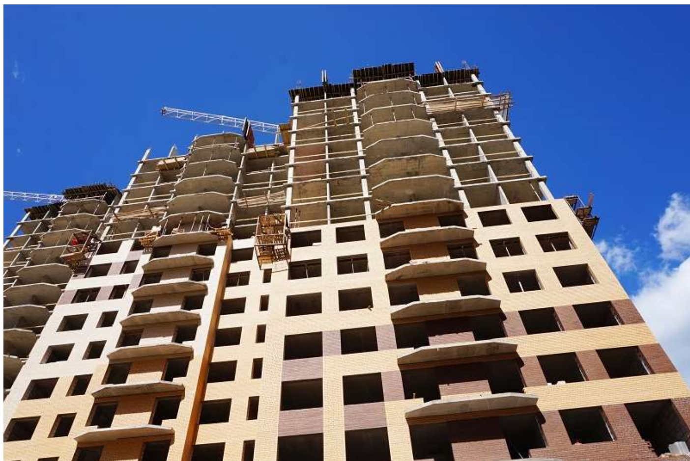
Вид на корпус 6 секции 19-20 со стороны Ленинградской ул.
