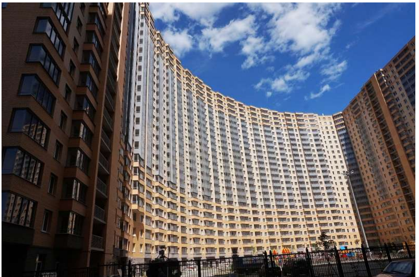
Вид на секции 1-9 со двора
