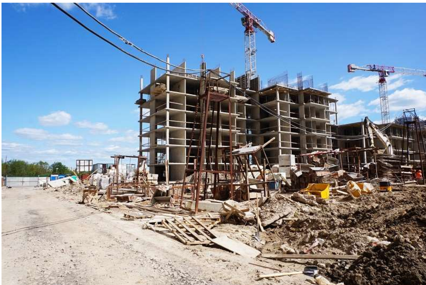
Вид на корпус 1 секции 1-3 со стороны Берёзовой ул.
