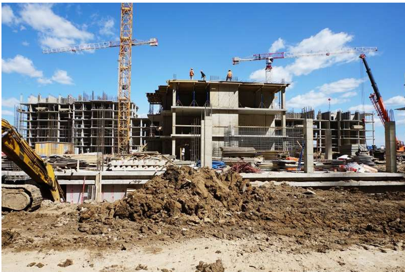
Вид на корпуса 3 и 1 со стороны Берёзовой ул.
