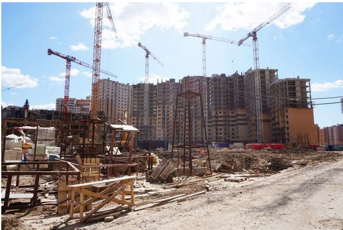
Вид на корпус 6 секции 20-15 со стороны Областной ул.
