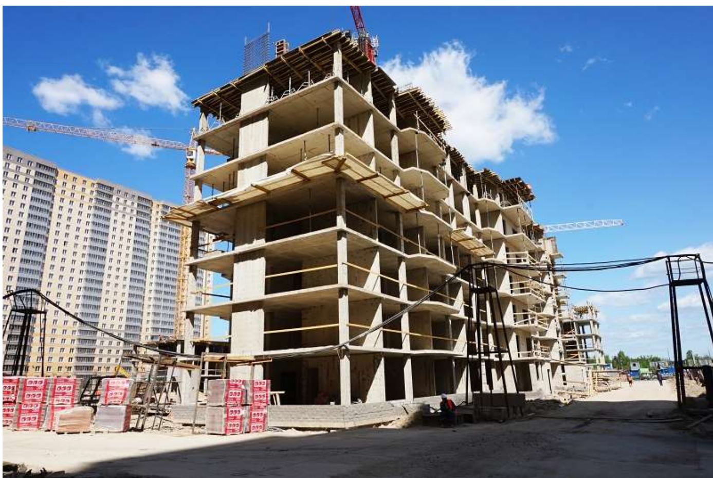
Вид на корпус 5 секции 14-13 со стороны Каштановой ал.
