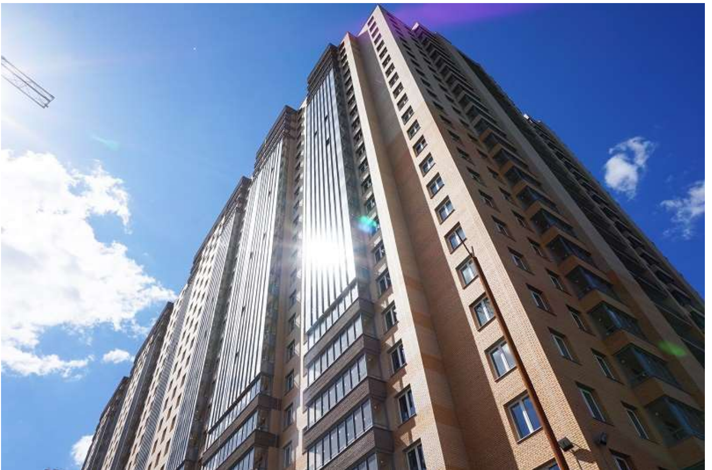
Вид на секции 10-8 с Областной ул.
