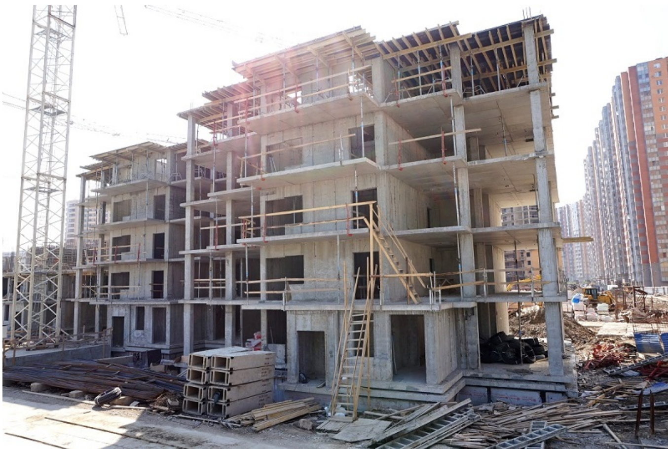
Вид на корпус 1 секции 1-2 со стороны Областной ул.
