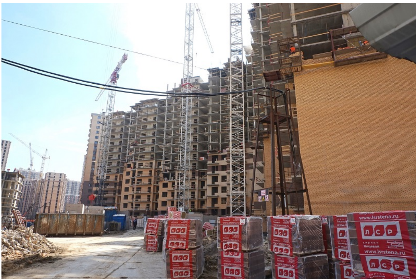
Вид на корпус 6 секции 20-18 со стороны Каштановой ал.
