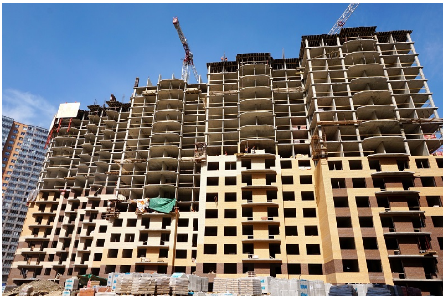
Вид на корпус 6 секции 17-20 со стороны Каштановой ал.
