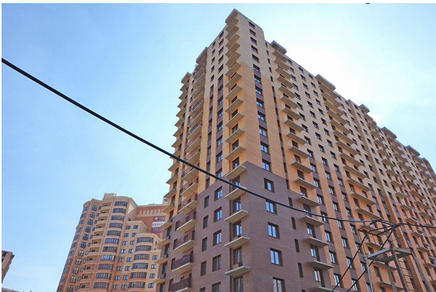
Вид на секции 9-8 со стороны Областной ул.
