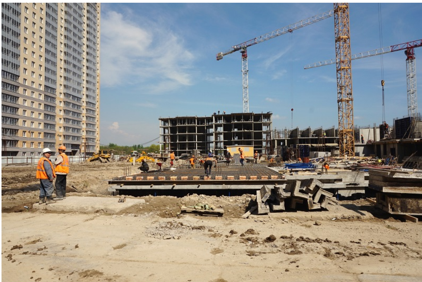
Вид на корпуса 2, 3 и 1 со стороны Берёзовой ул.
