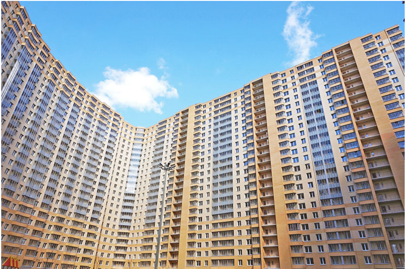
Вид на секции 3-9 со двора
