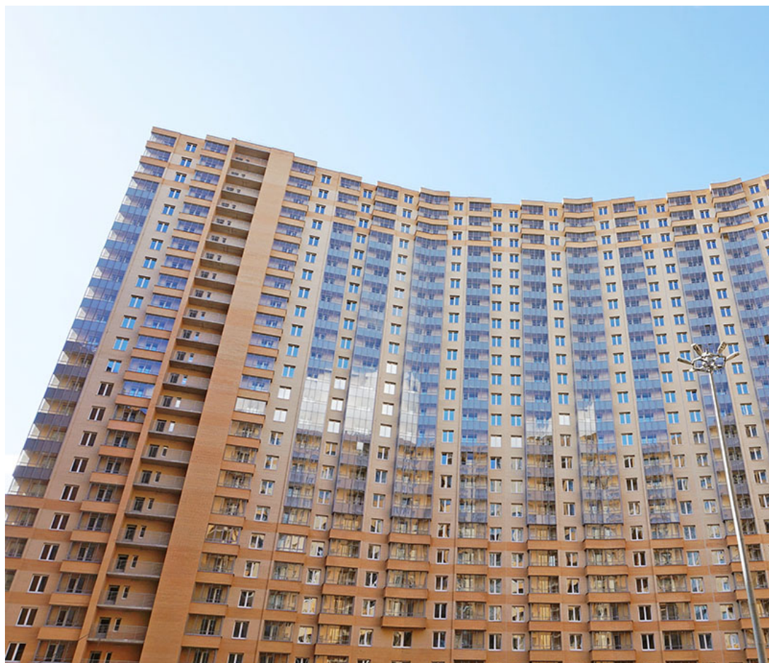
Вид на секции 1-4 со двора
