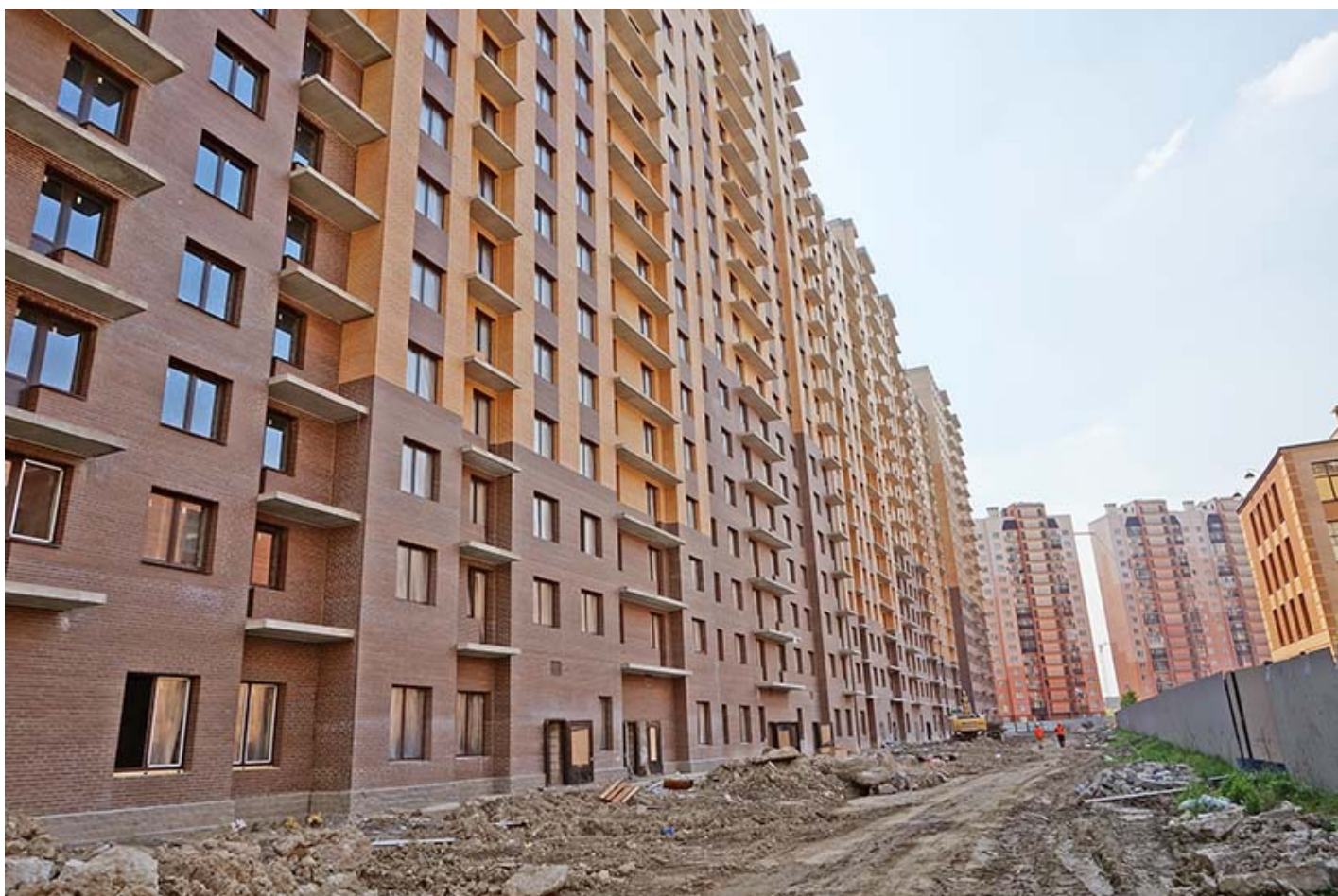
Вид на секции 5-1 со стороны Берёзовой ул.
