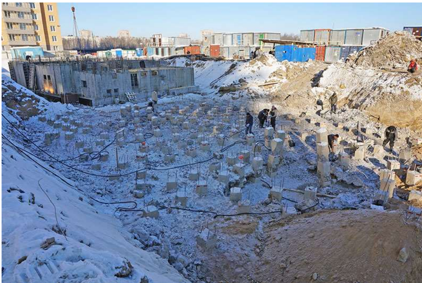
Вид на корпус 1 секции 1-3 со стороны Каштановой ал.
