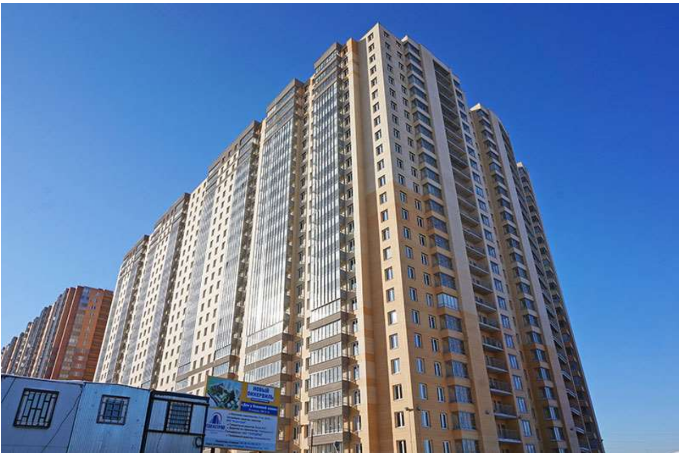
Вид на секции 11-7 со стороны Областной ул.
