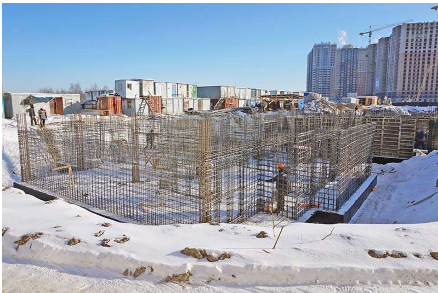
Вид на корпус 1 секции 1-2 со стороны Берёзовой ул.
