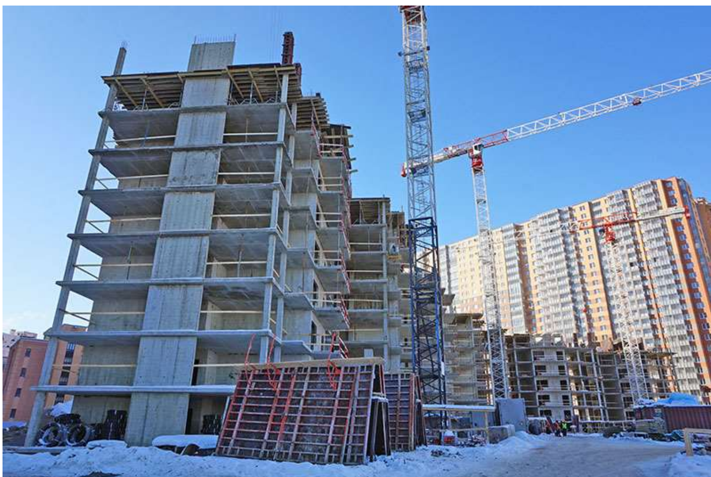
Вид на корпус 6 секции 20-15 со стороны Каштановой ал.
