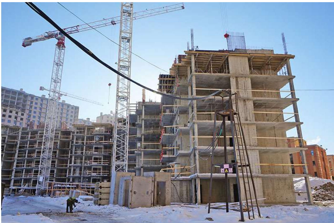
Вид на корпус 6 секции 19-15 со стороны Берёзовой ул.
