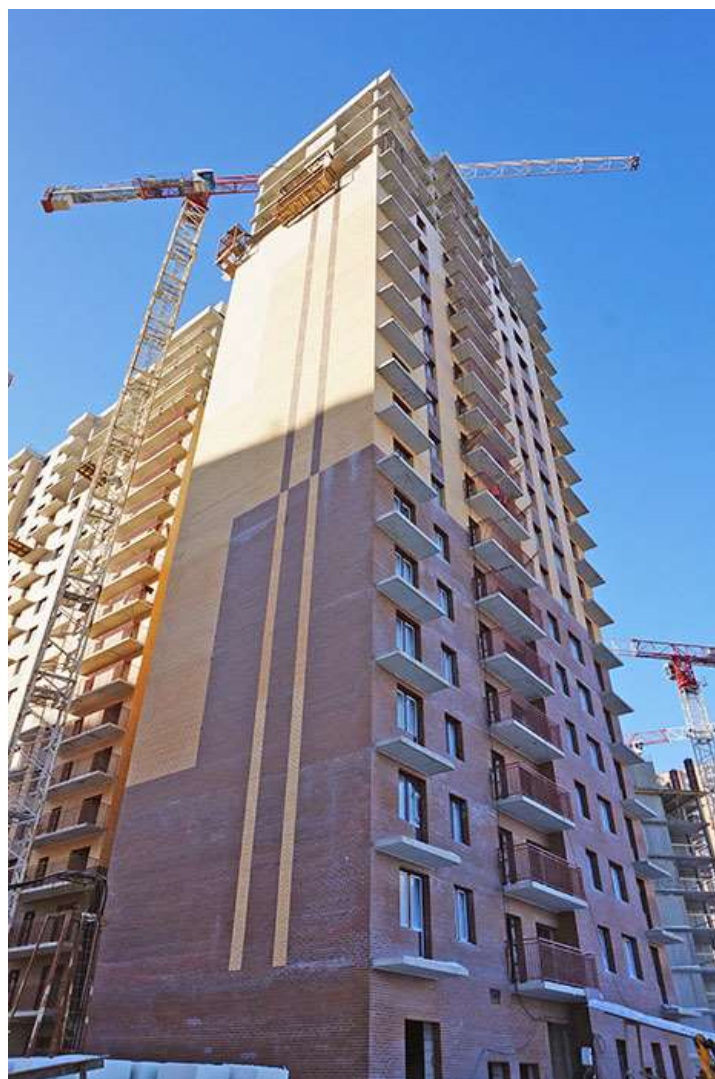
Вид на секции 8-9 со стороны Областной ул.
