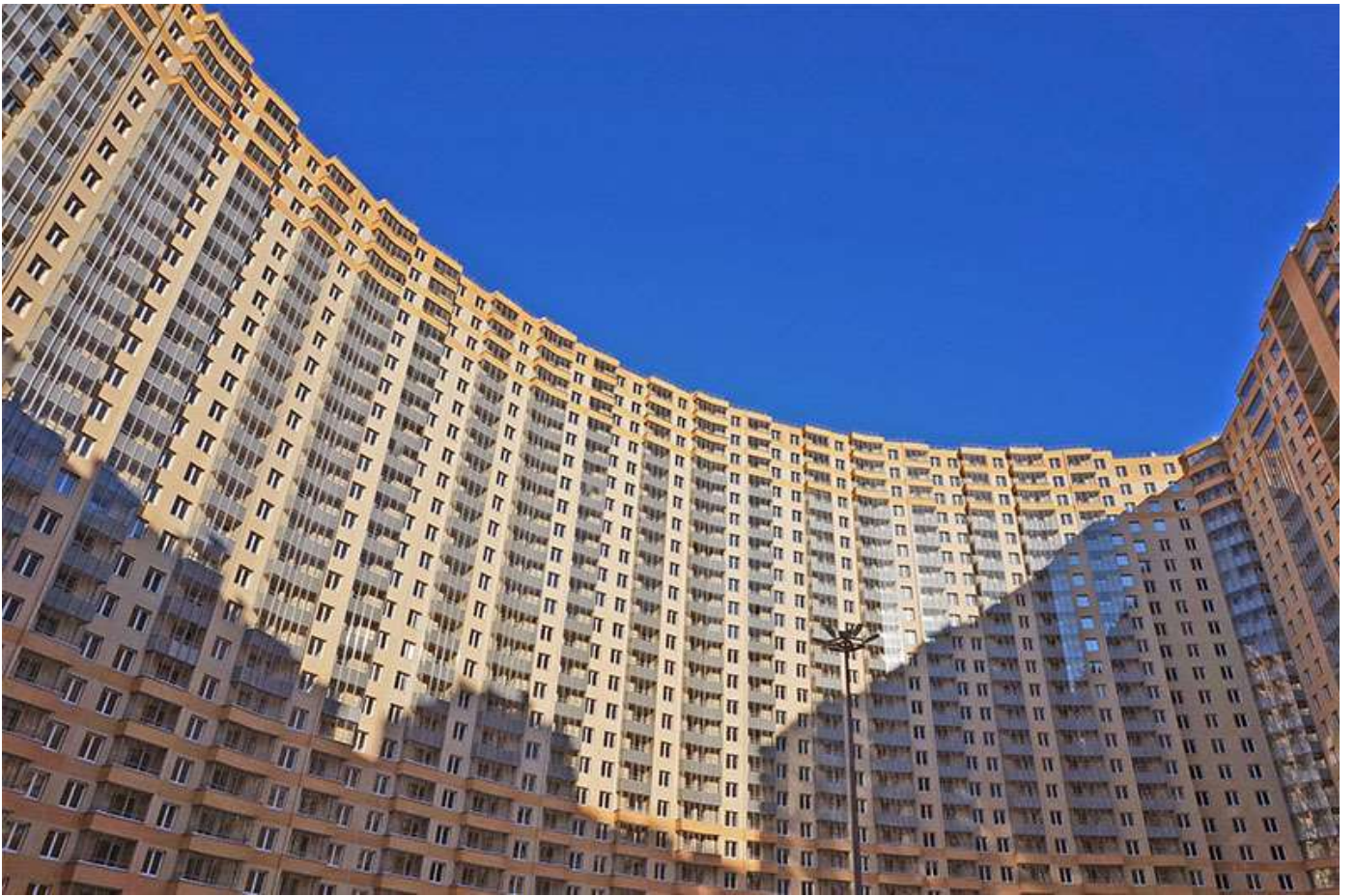
Вид на секции 3-8 со двора
