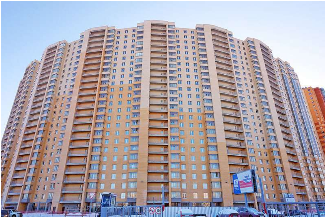
Вид на секции 7-1 с Областной ул.
