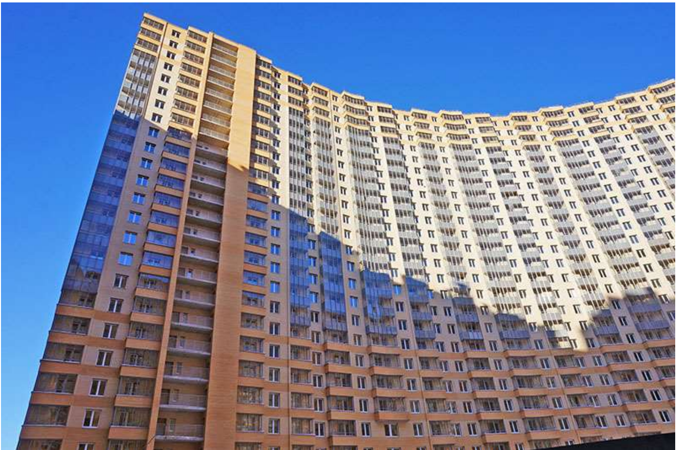
Вид на секции 1-4 со двора
