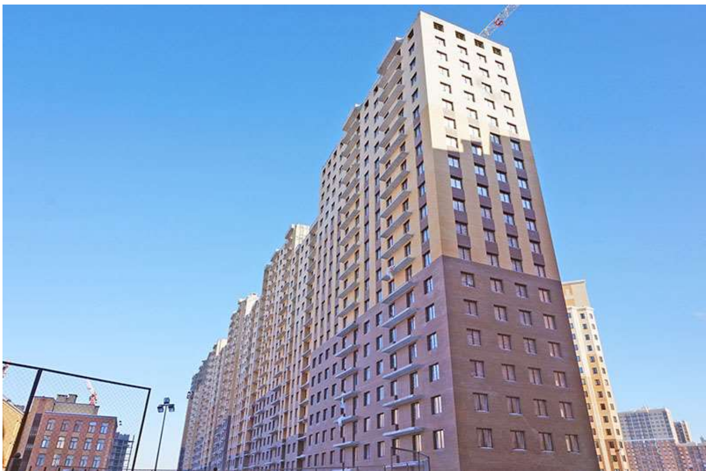
Вид на секции 9-1 со стороны Ленинградской ул.
