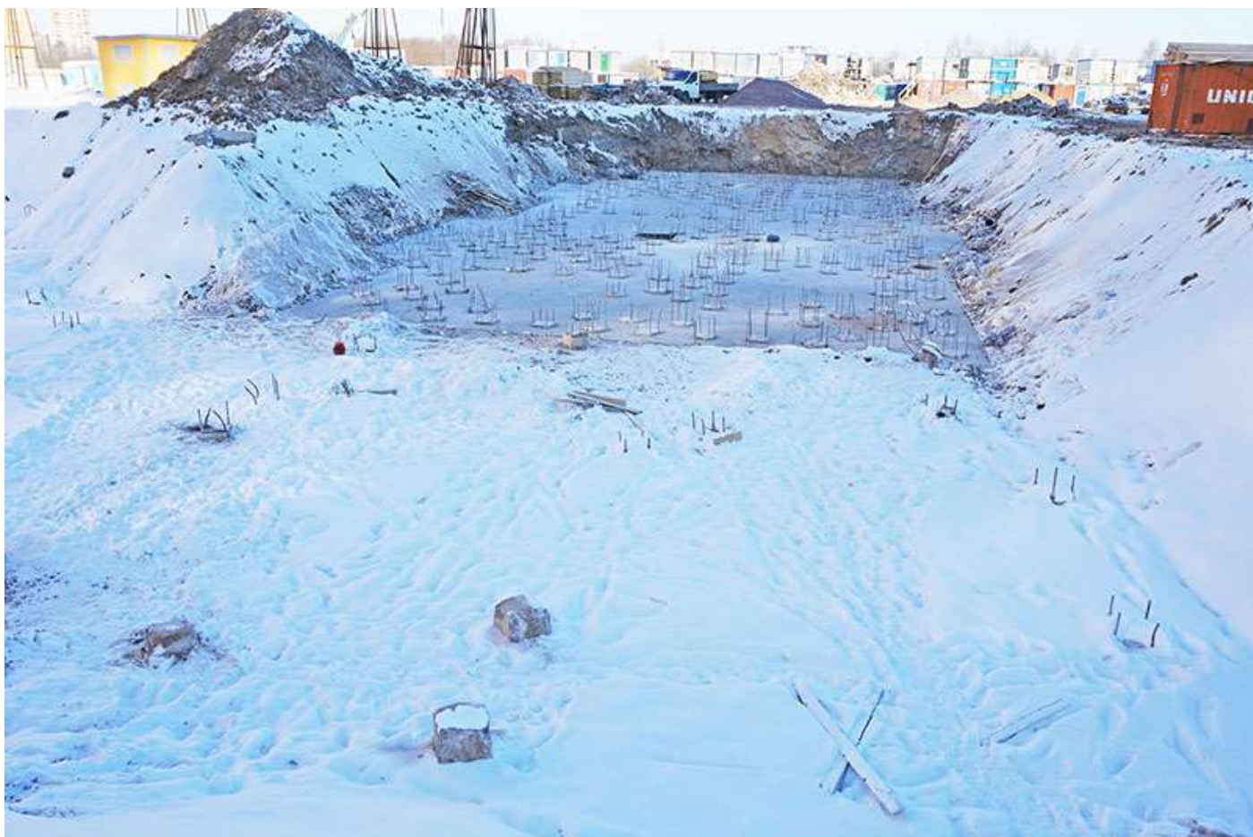
Вид на корпус 3 со стороны Берёзовой ул.
