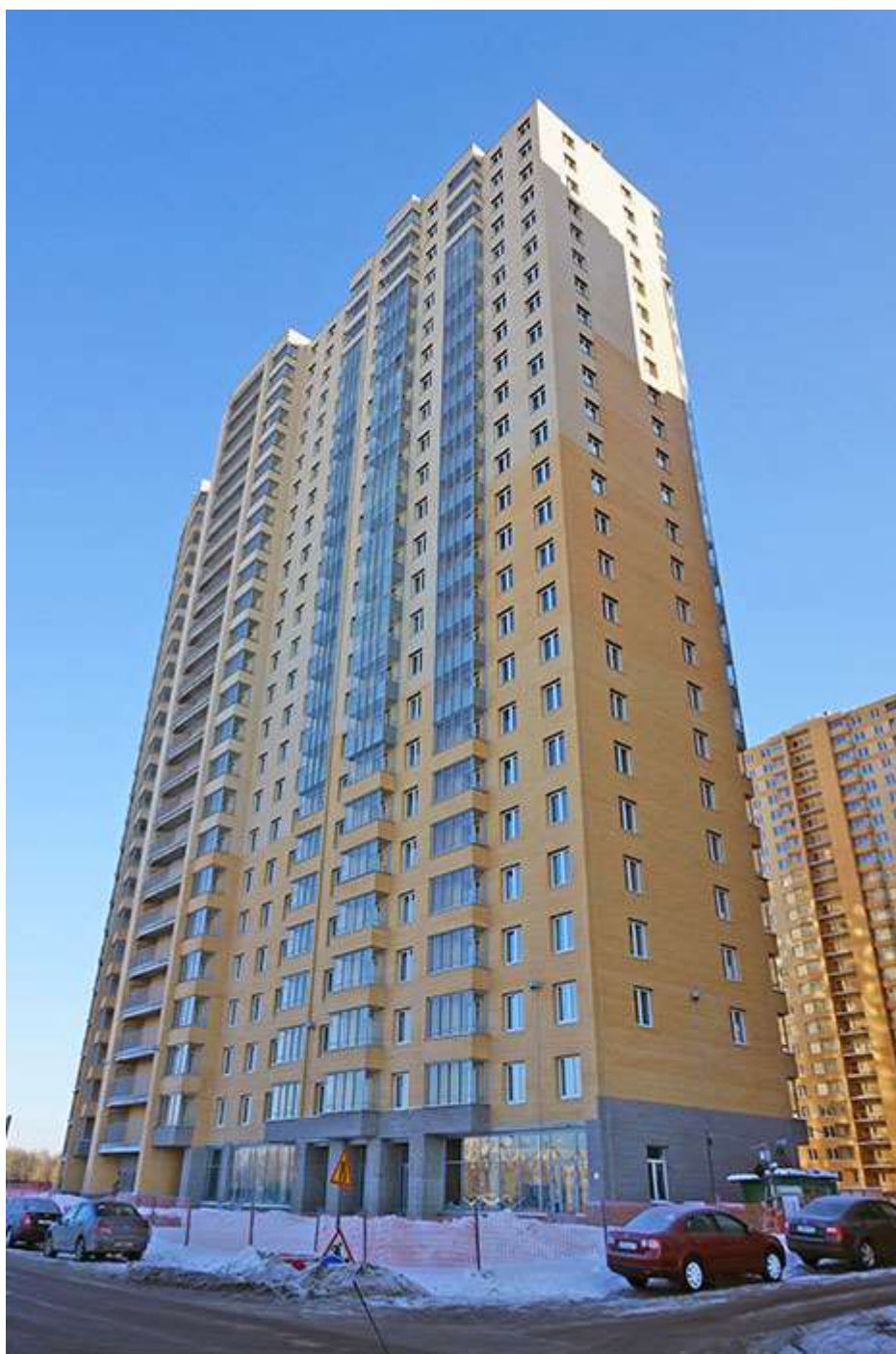
Вид на секции 2-1 со Областной ул.
