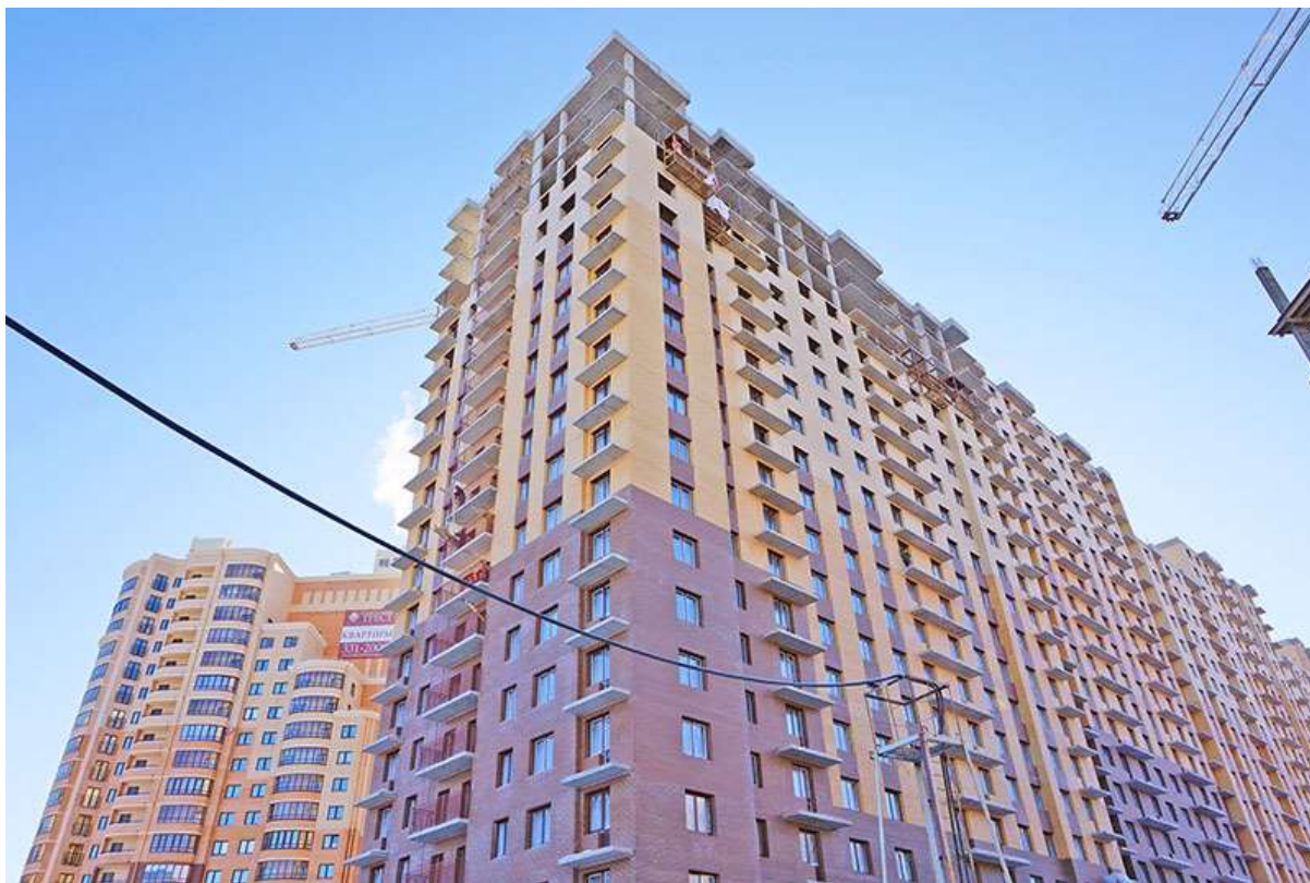
Вид на секции 9-5 со стороны Областной ул.
