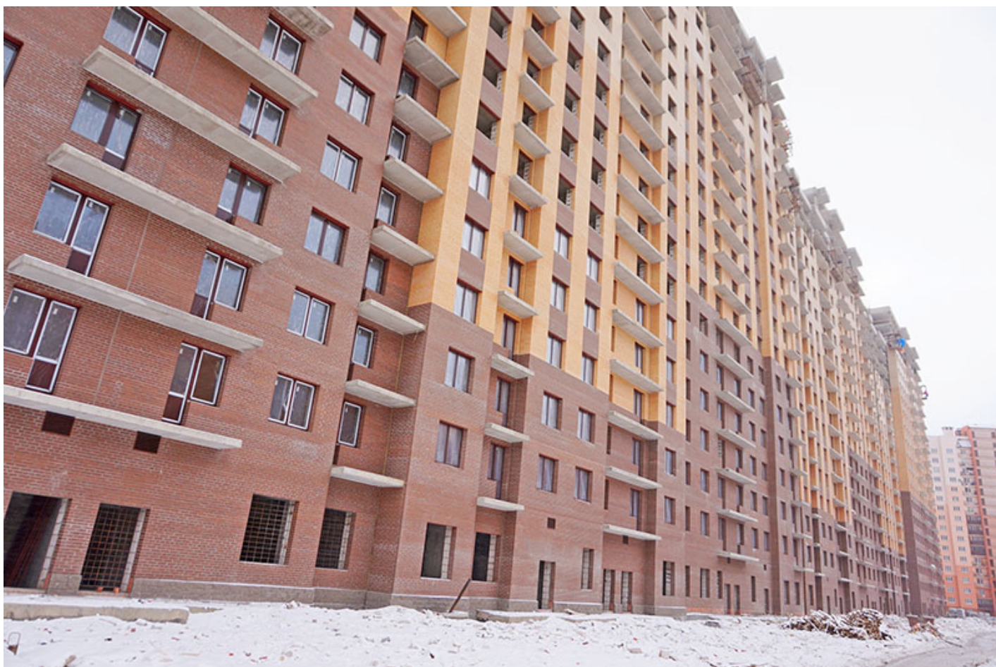
Вид на секции 6-1 со стороны Берёзовой ул.
