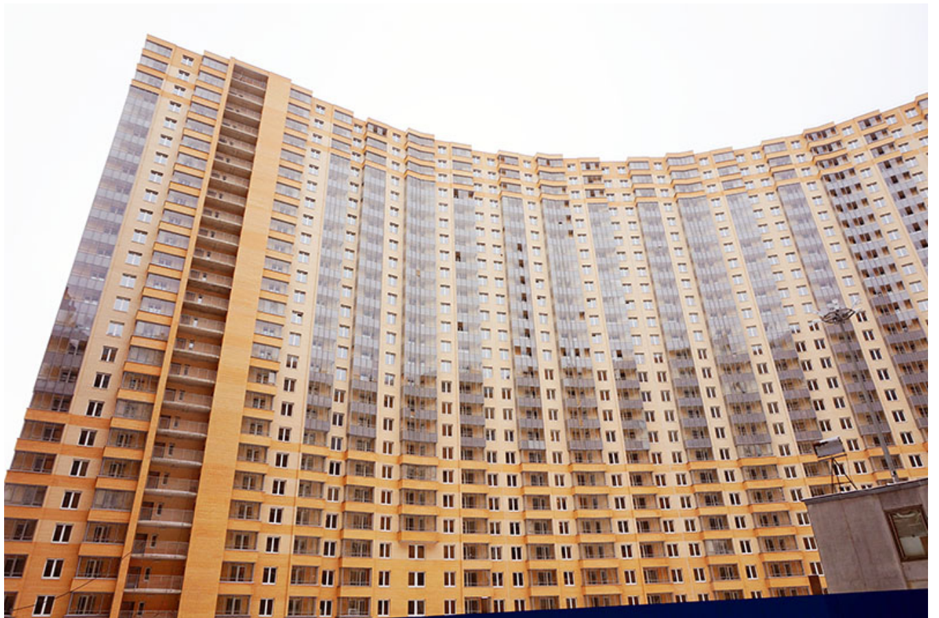
Вид на секции 1-5 со двора
