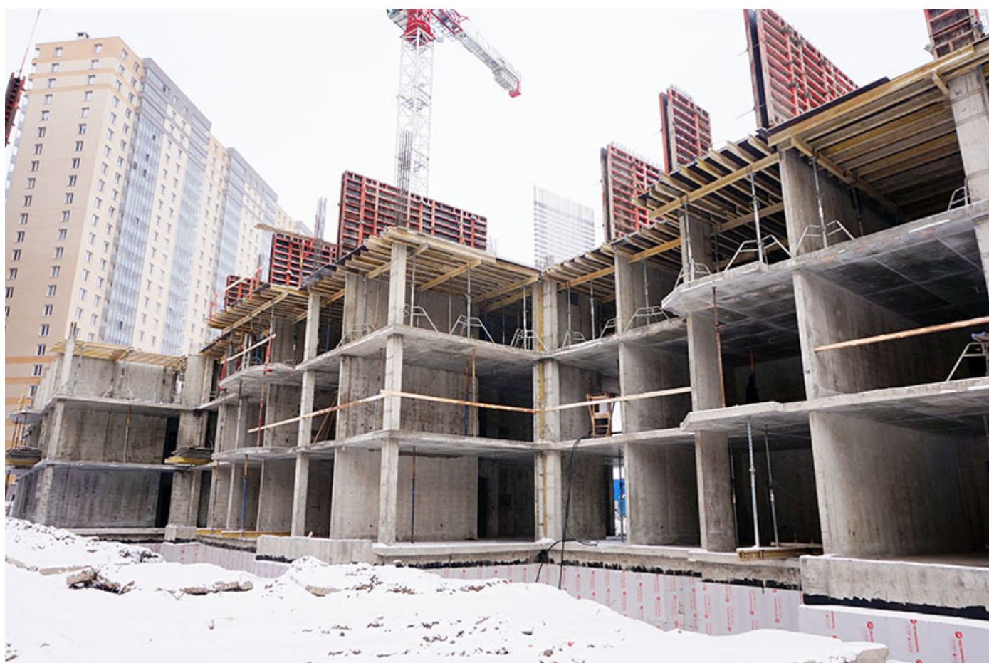
Вид на корпус 6 секции 15-17 со стороны Каштановой ал.
