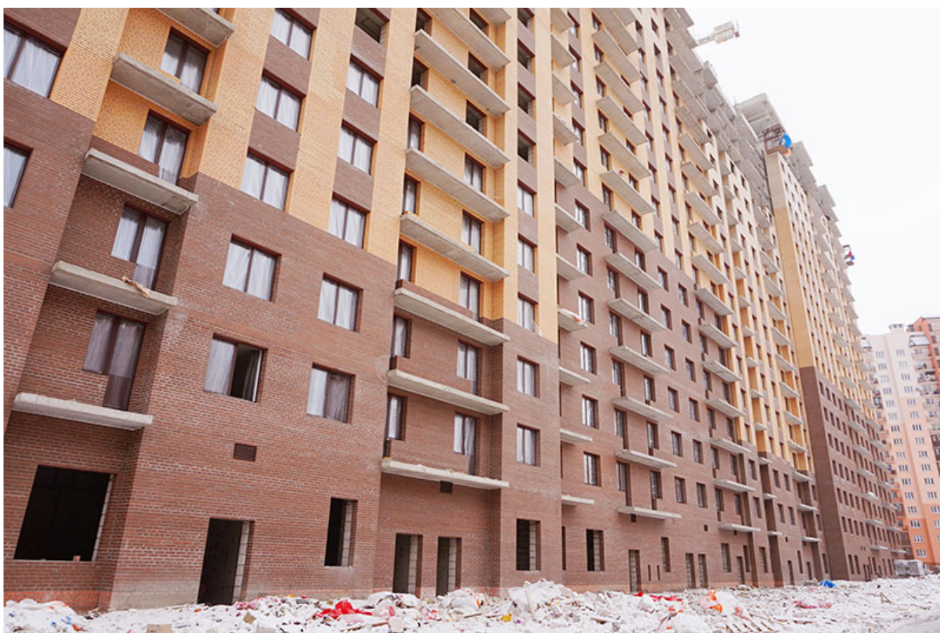
Вид на секции 3-1 со стороны Берёзовой ул.
