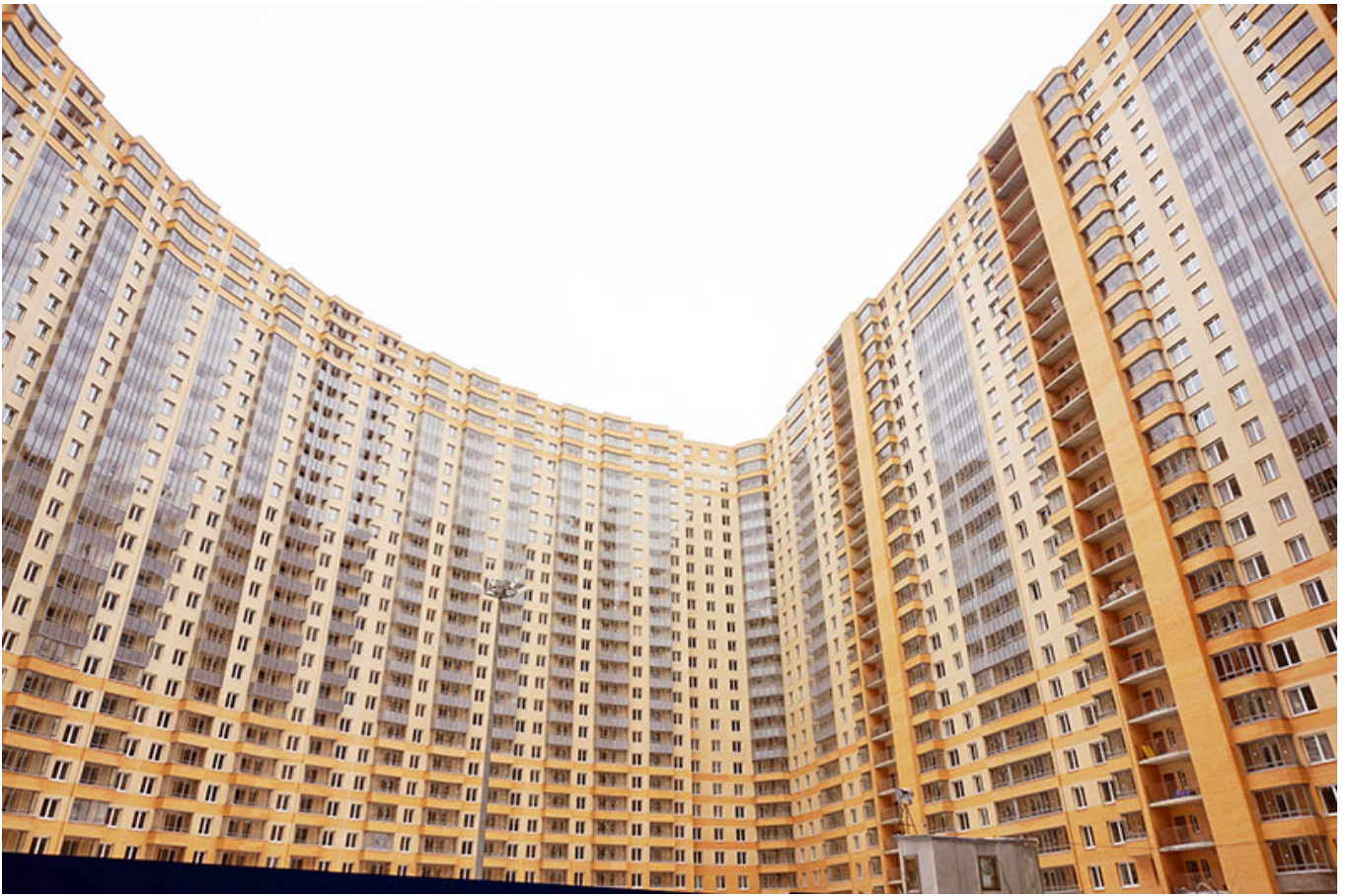
Вид на секции 4-10 со двора
