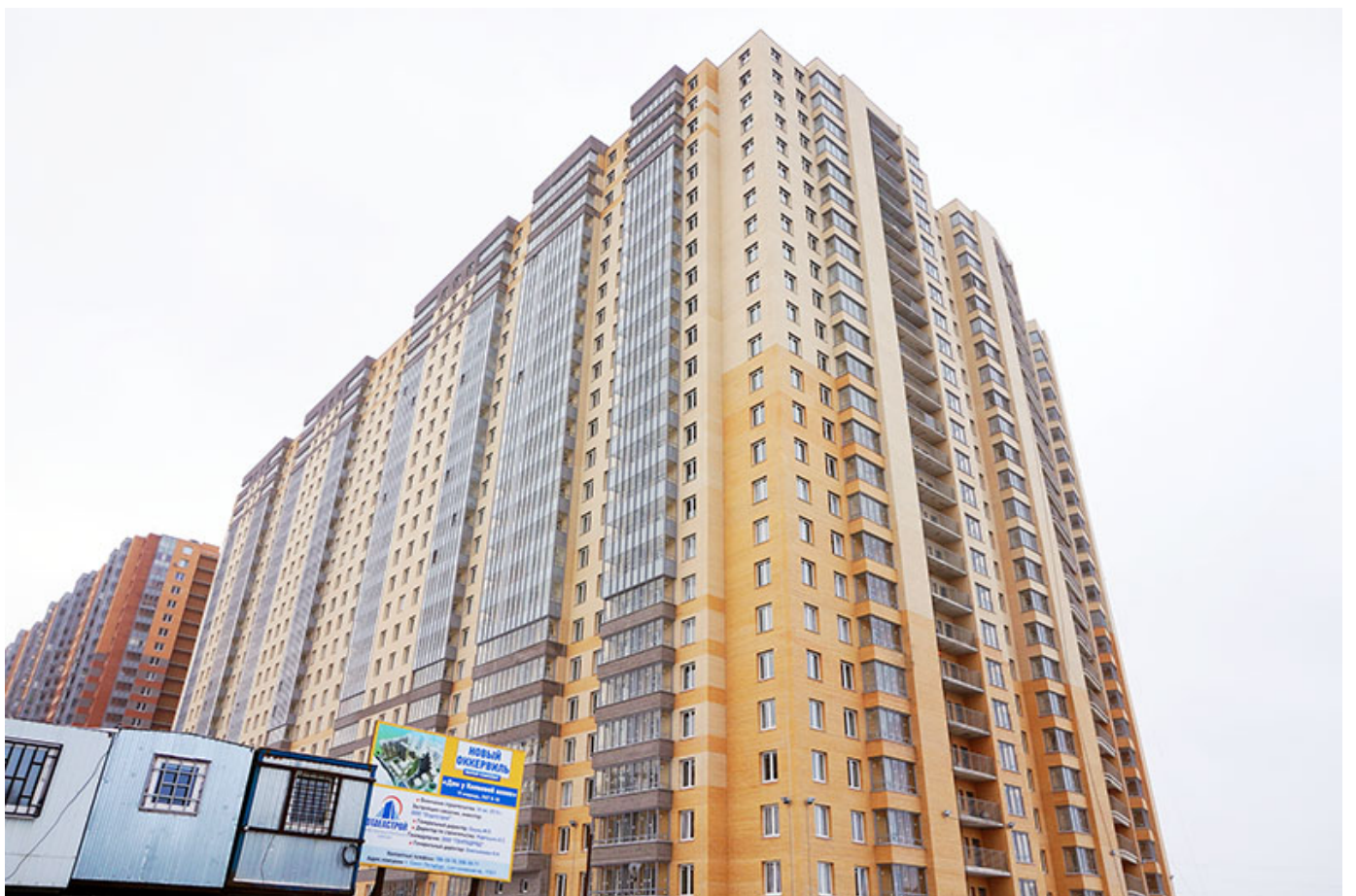
Вид на секции 11-7 со стороны Областной ул.
