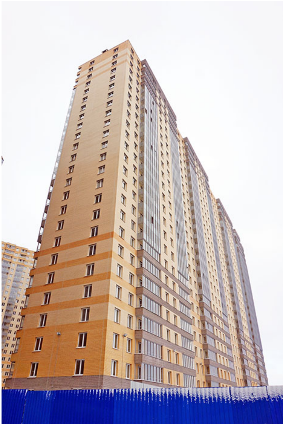
Вид на секции 11-10 со стороны Берёзовой ул.
