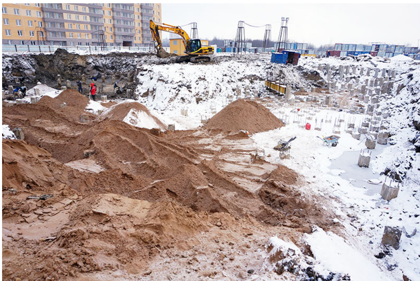
Вид на корпуса 2 и 3 со стороны Берёзовой ул.
