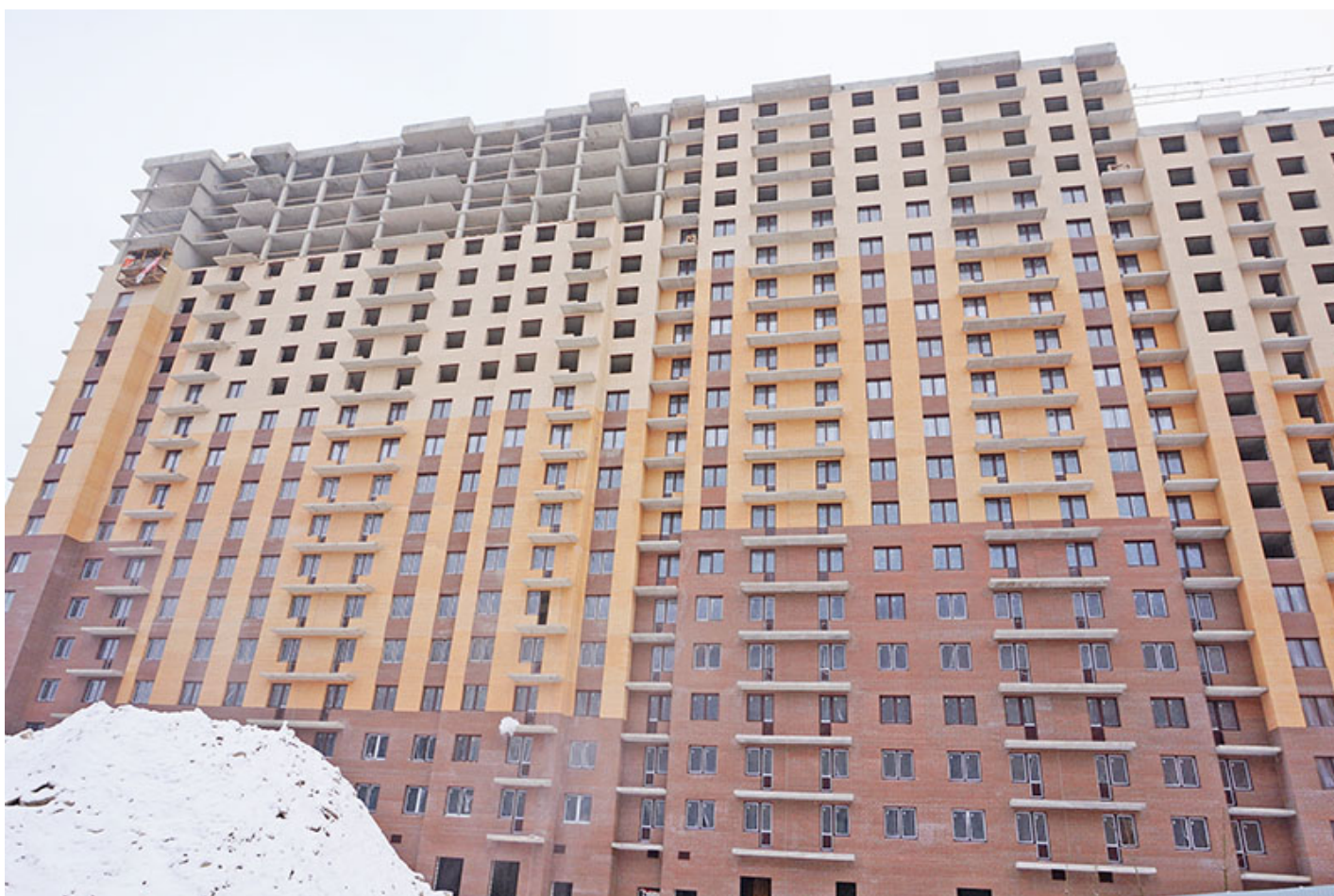
Вид на секцию 9-8 со стороны Берёзовой ул.
