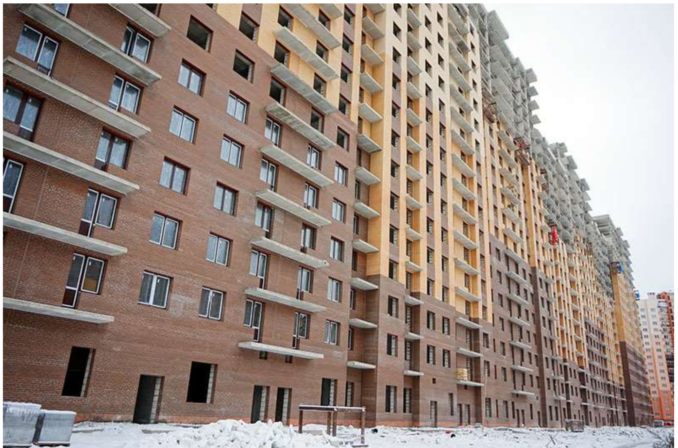
Вид на секции 6-1 со стороны Берёзовой ул.
