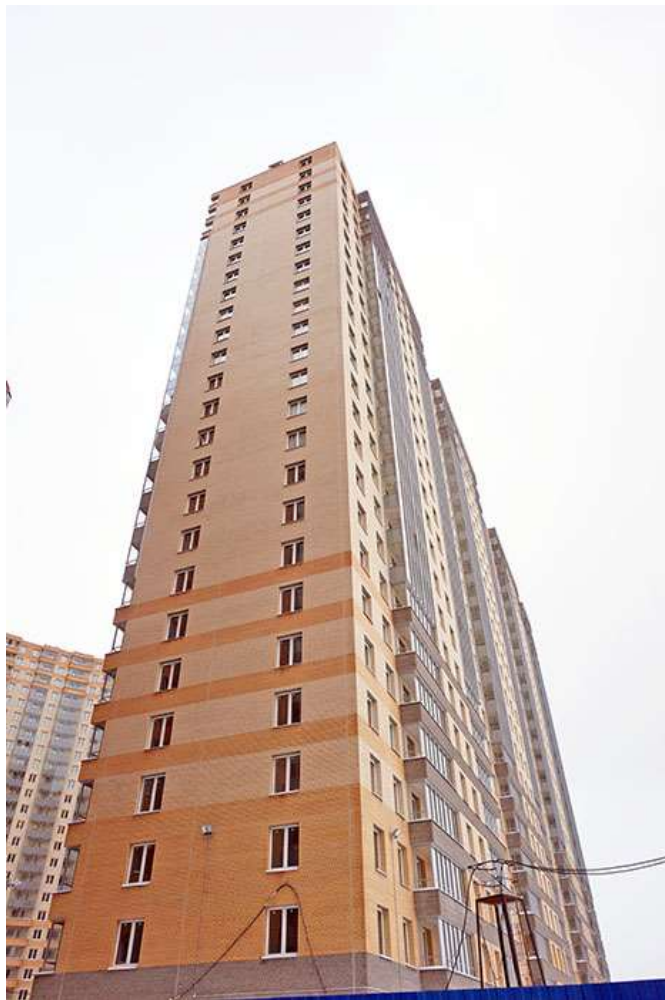
Вид на секции 11-10 со стороны Берёзовой ул.
