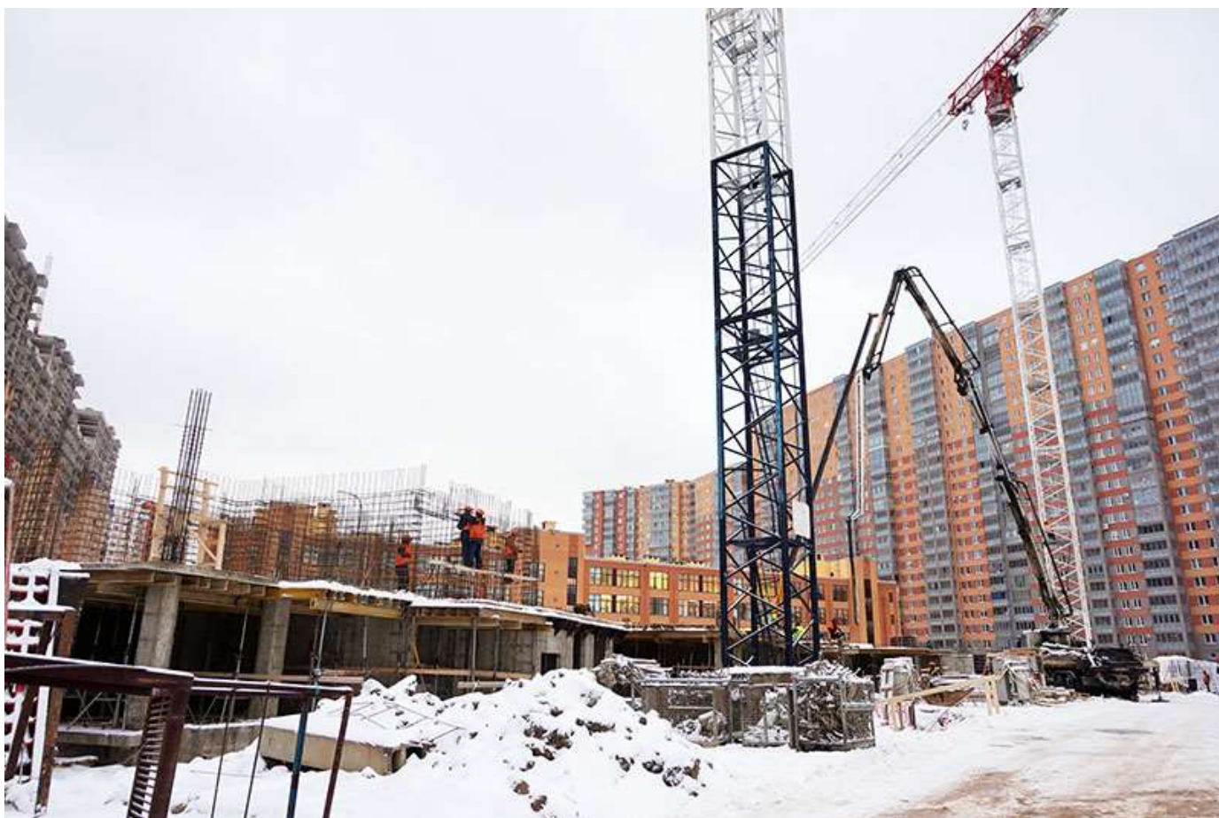
Вид на корпус 6 со стороны Областной ул.
