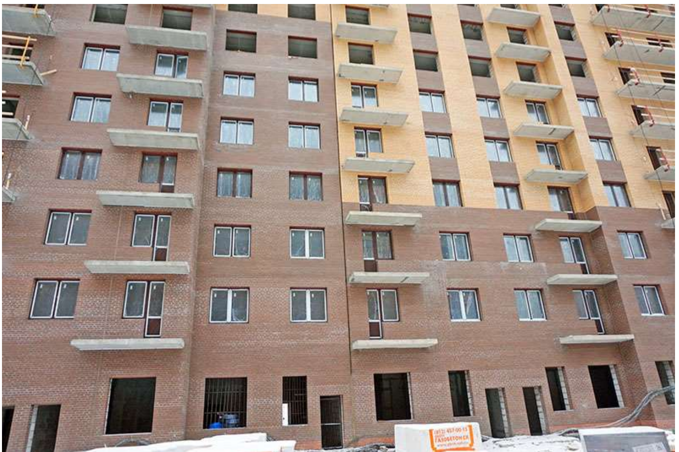
Вид на секцию 7 со стороны Каштановой ал.
