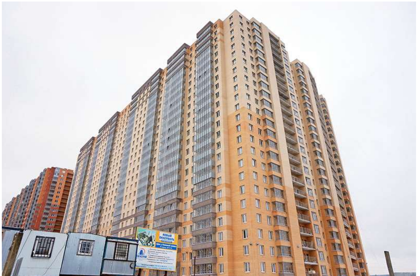
Вид на секции 11-7 со стороны Областной ул.
