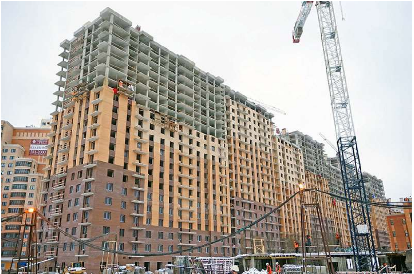
Вид на секции 9-1 со стороны Областной ул.
