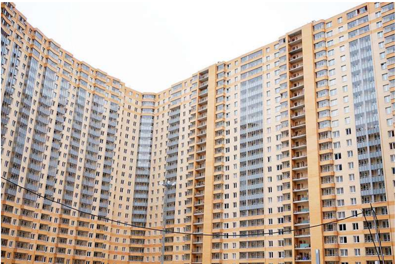
Вид на секции 6-10 со двора
