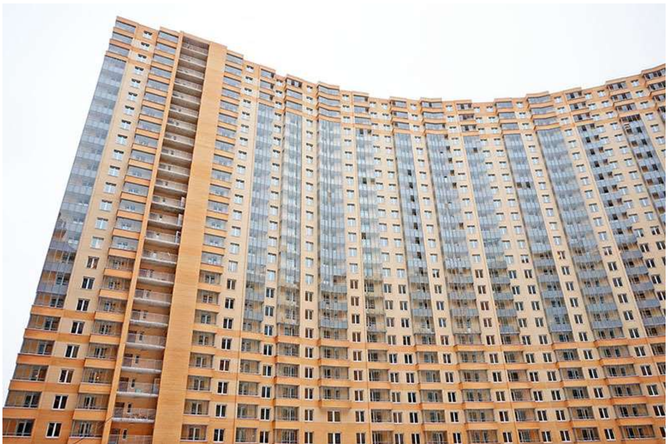
Вид на секции 1-5 со двора
