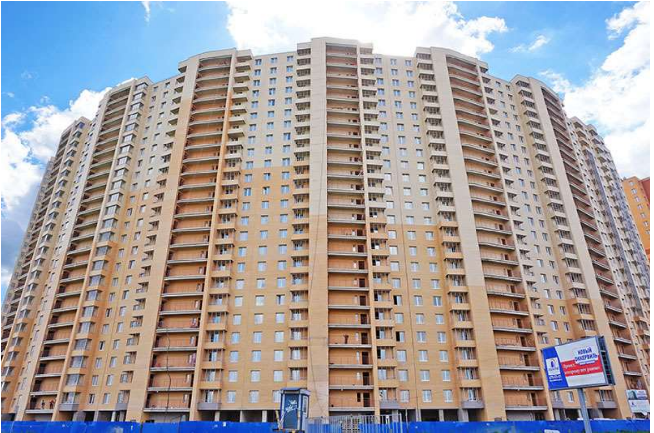
Вид на секции 7-1 с Областной ул.
