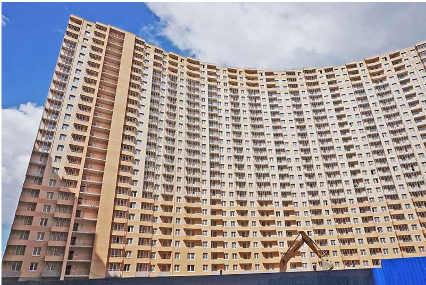
Вид на секции 1-5 со двора
