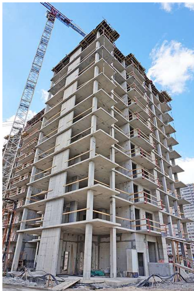
Вид на секцию 1 со стороны Областной ул.
