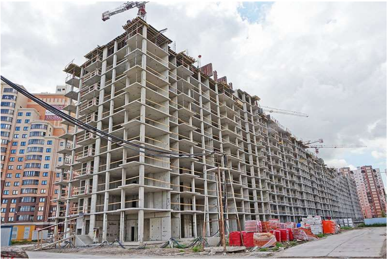
Вид на секции 9-1 со стороны Областной ул.
