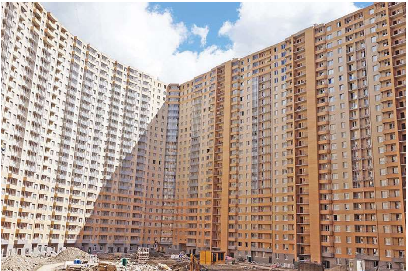
Вид на секции 5-11 со двора
