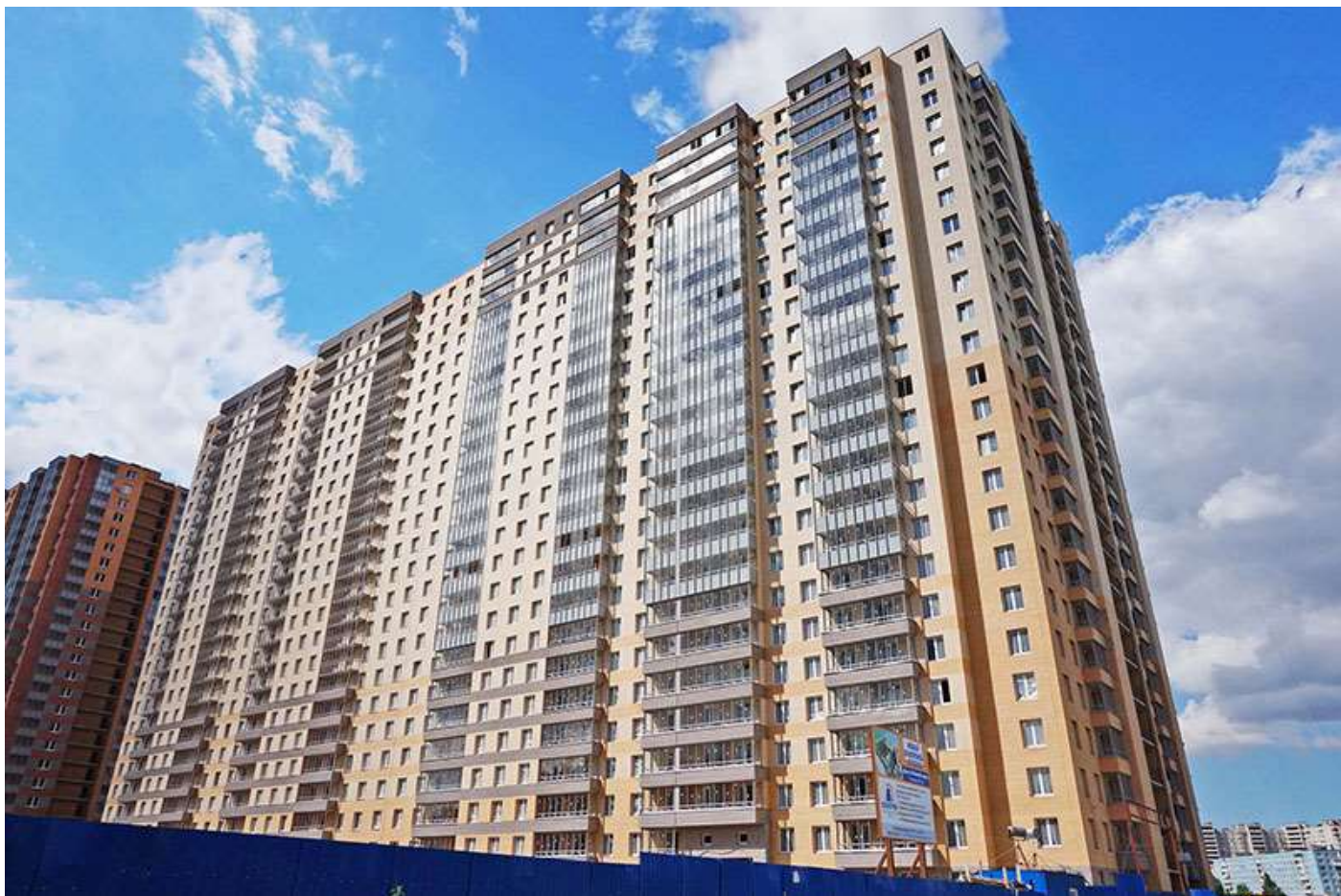
Вид на секции 11-8 со стороны Областной ул.
