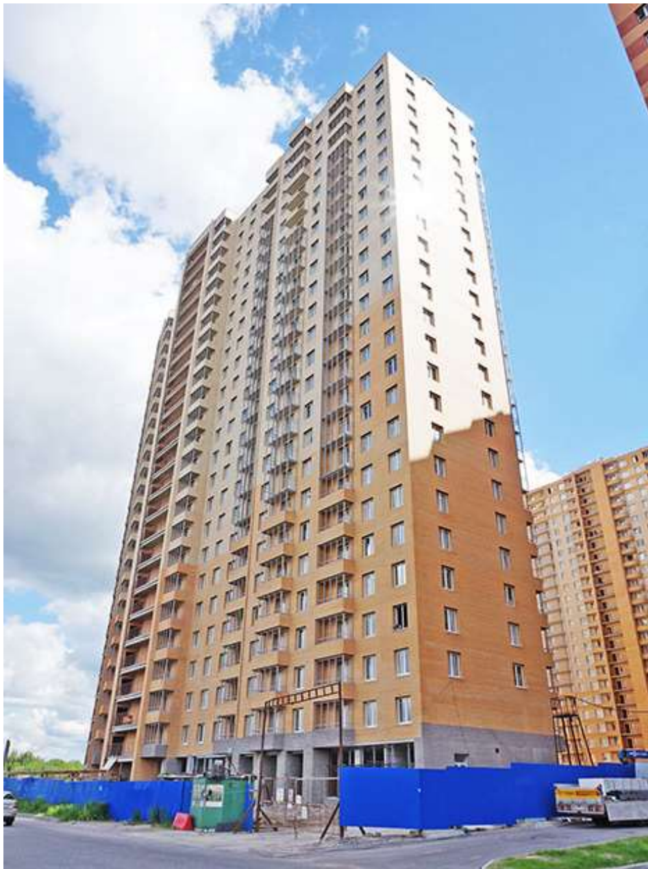
Вид на секции 2-1 со Областной ул.
