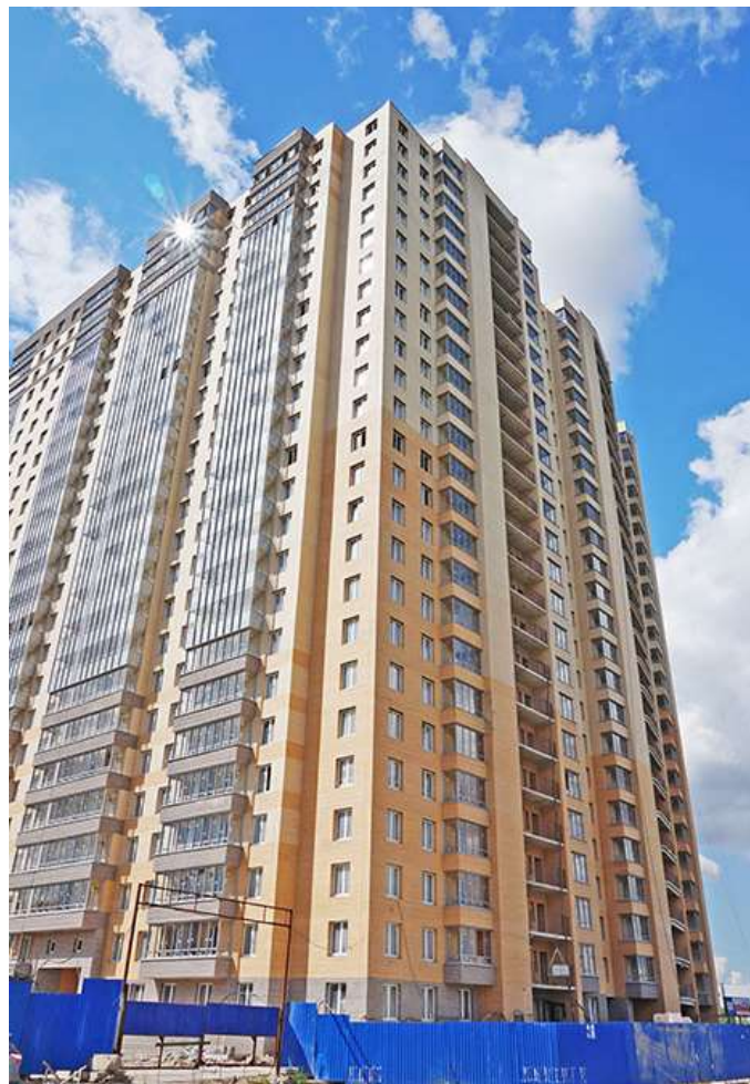
Вид на секции 9-8 со стороны Областной ул.
