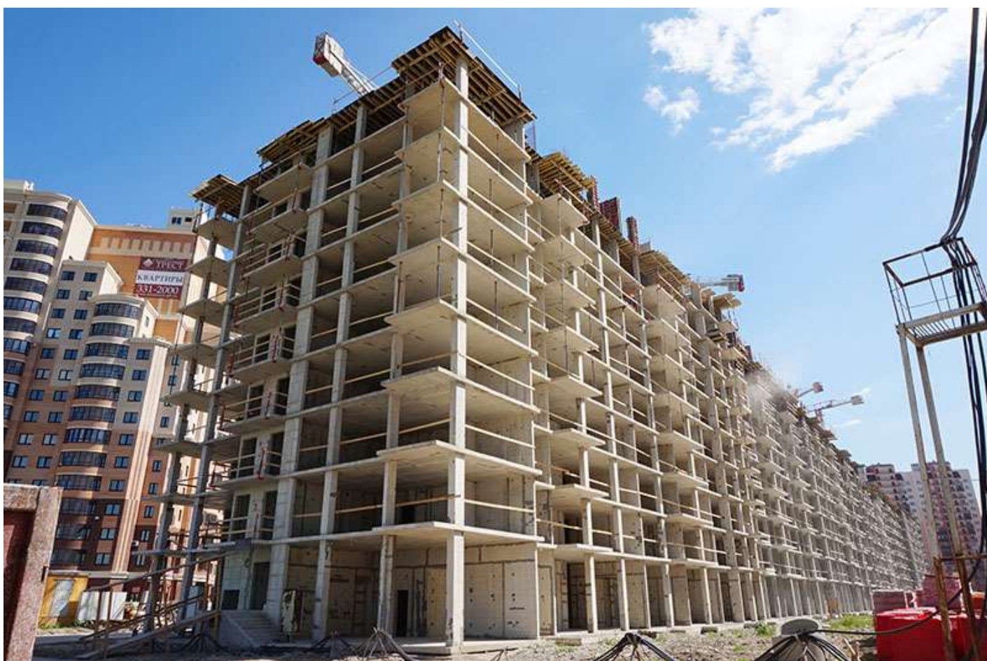
Вид на секции 9-1 со стороны Областной ул.
