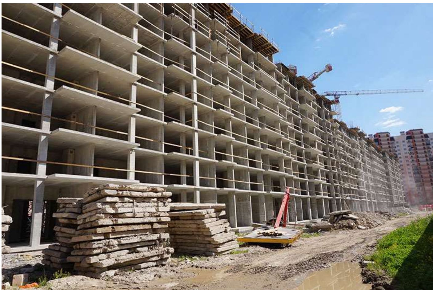
Вид на секции 7-1 со стороны Берёзовой ул.
