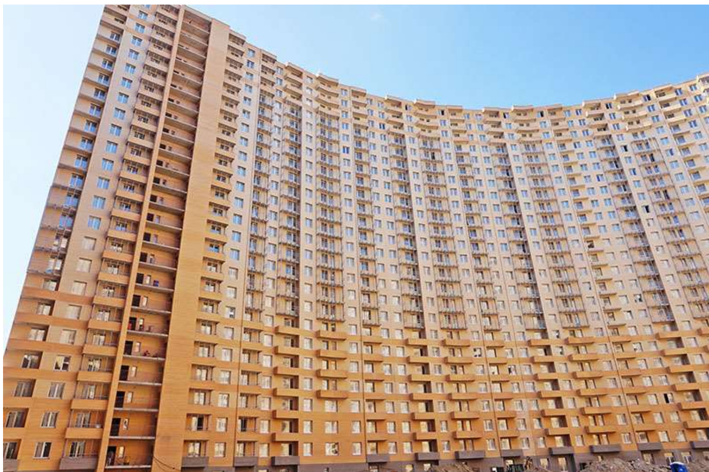
Вид на секции 1-5 со двора
