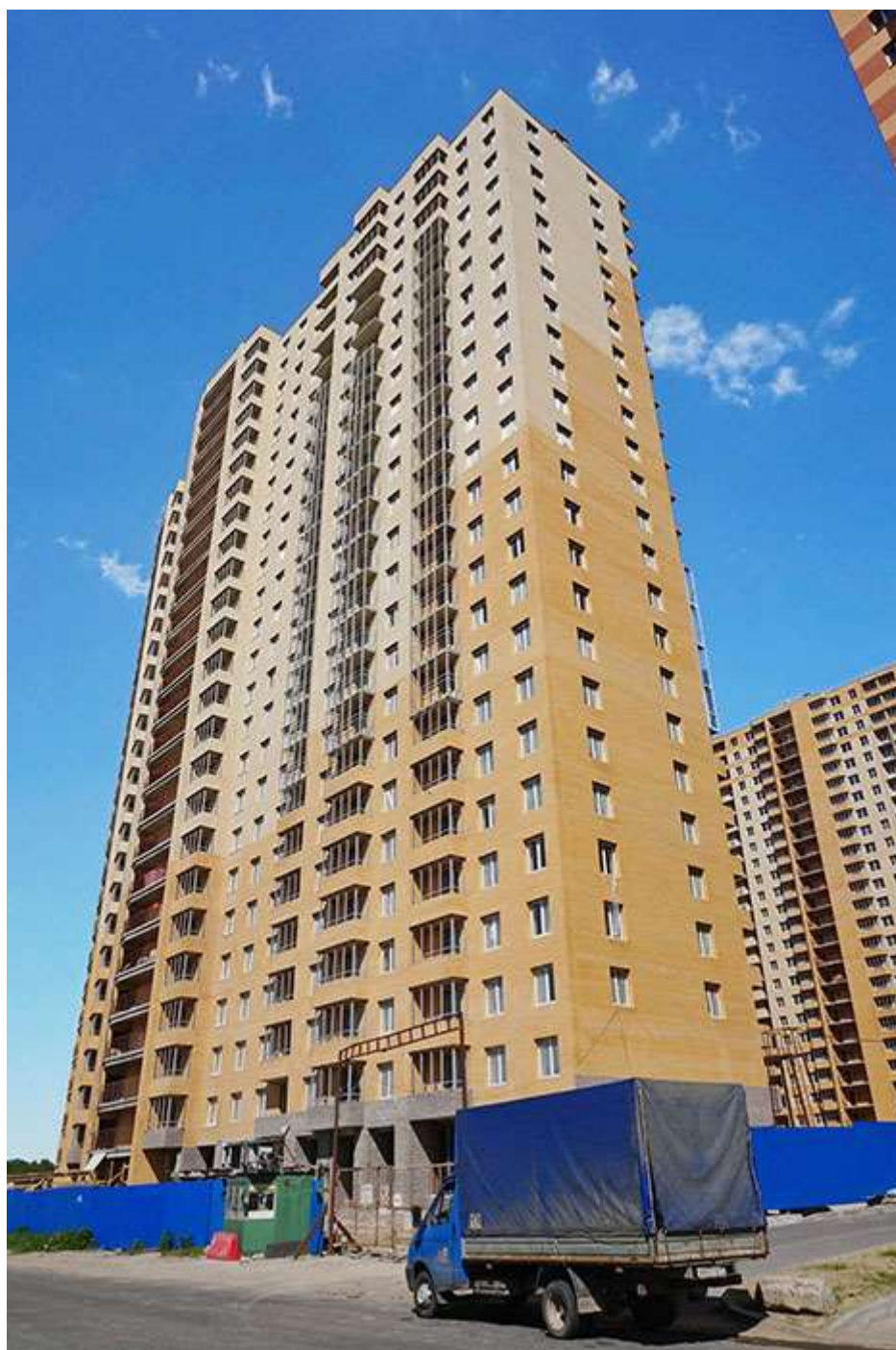
Вид на секции 1-2 со двора
