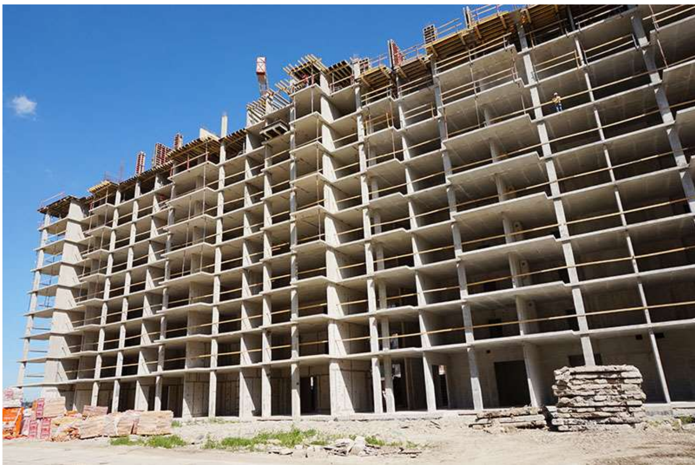
Вид на секции 9-8 со стороны Берёзовой ул.
