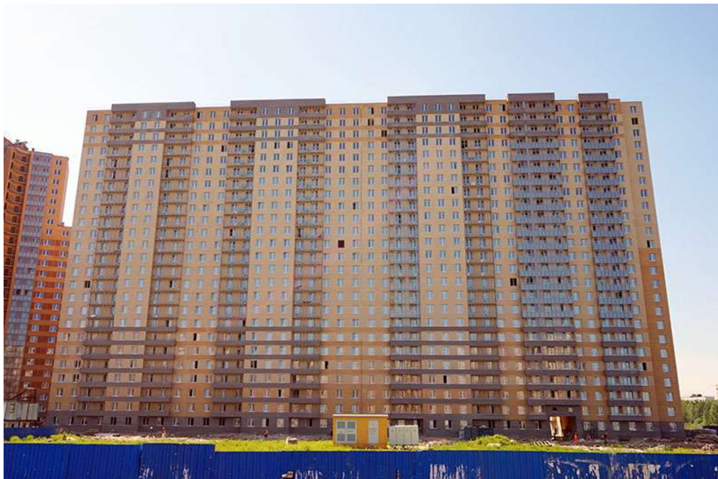
Вид на секции 11-8 со стороны Берёзовой ул.
