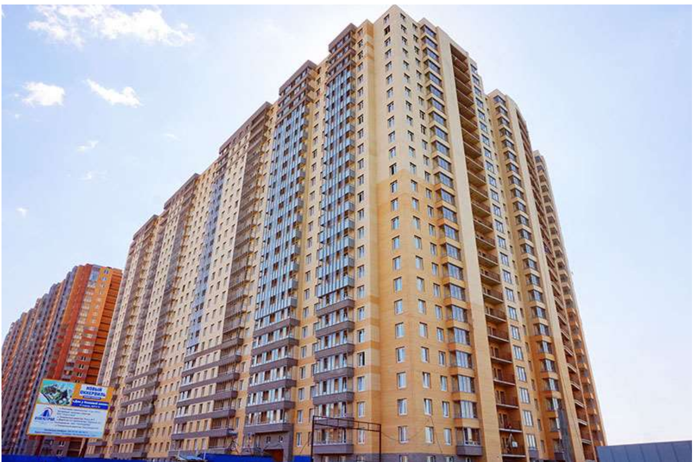
Вид на секции 11-8 со стороны Областной ул.
