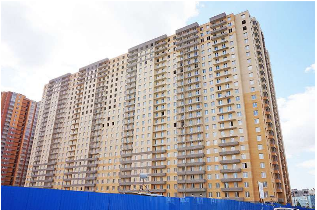
Вид на секции 11-8 со стороны Областной ул.
