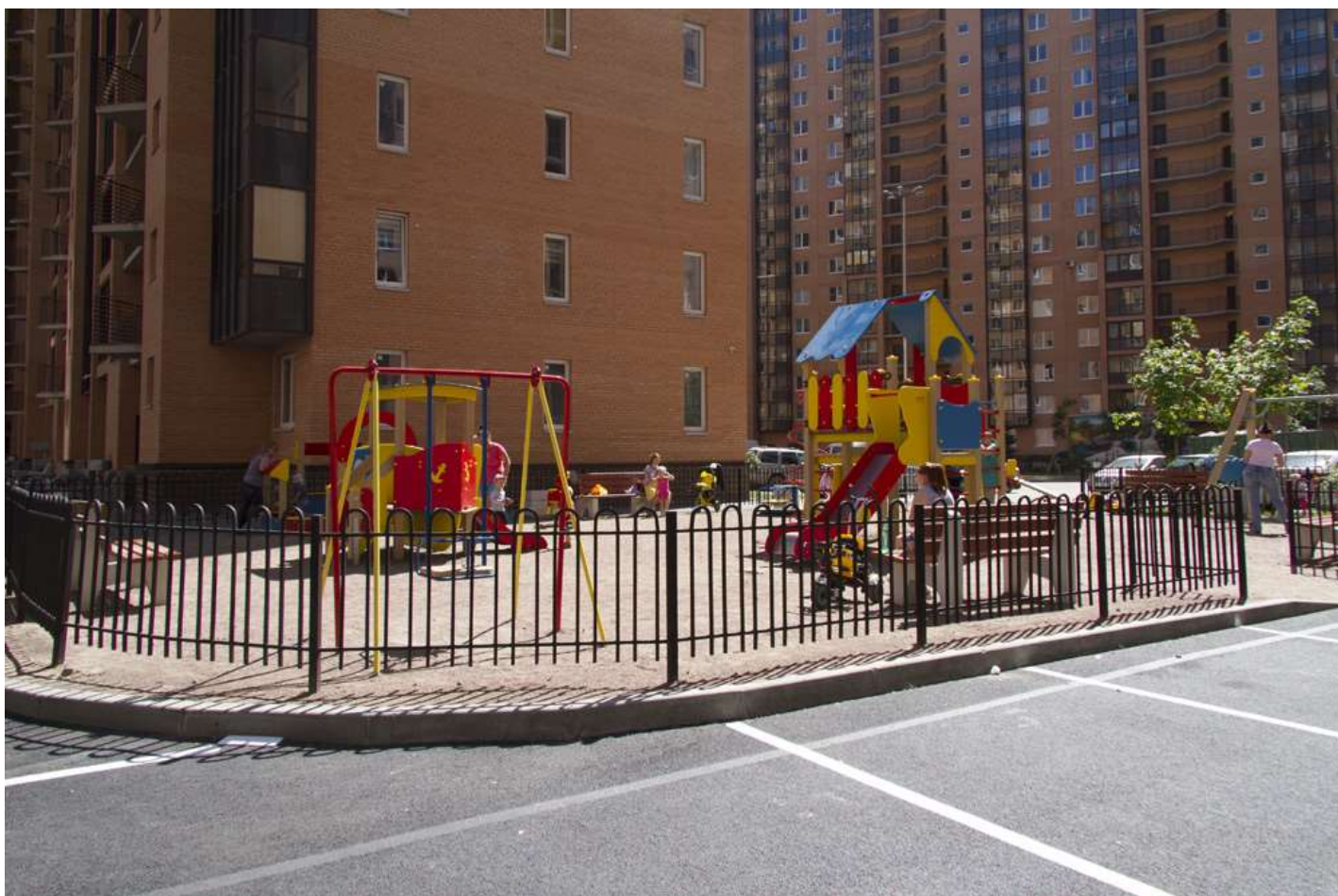
Благоустройство двора в 1-2-м пусках 3 очереди
