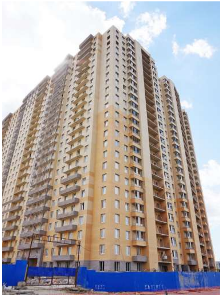
Вид на секции 9-7 с Областной ул.
