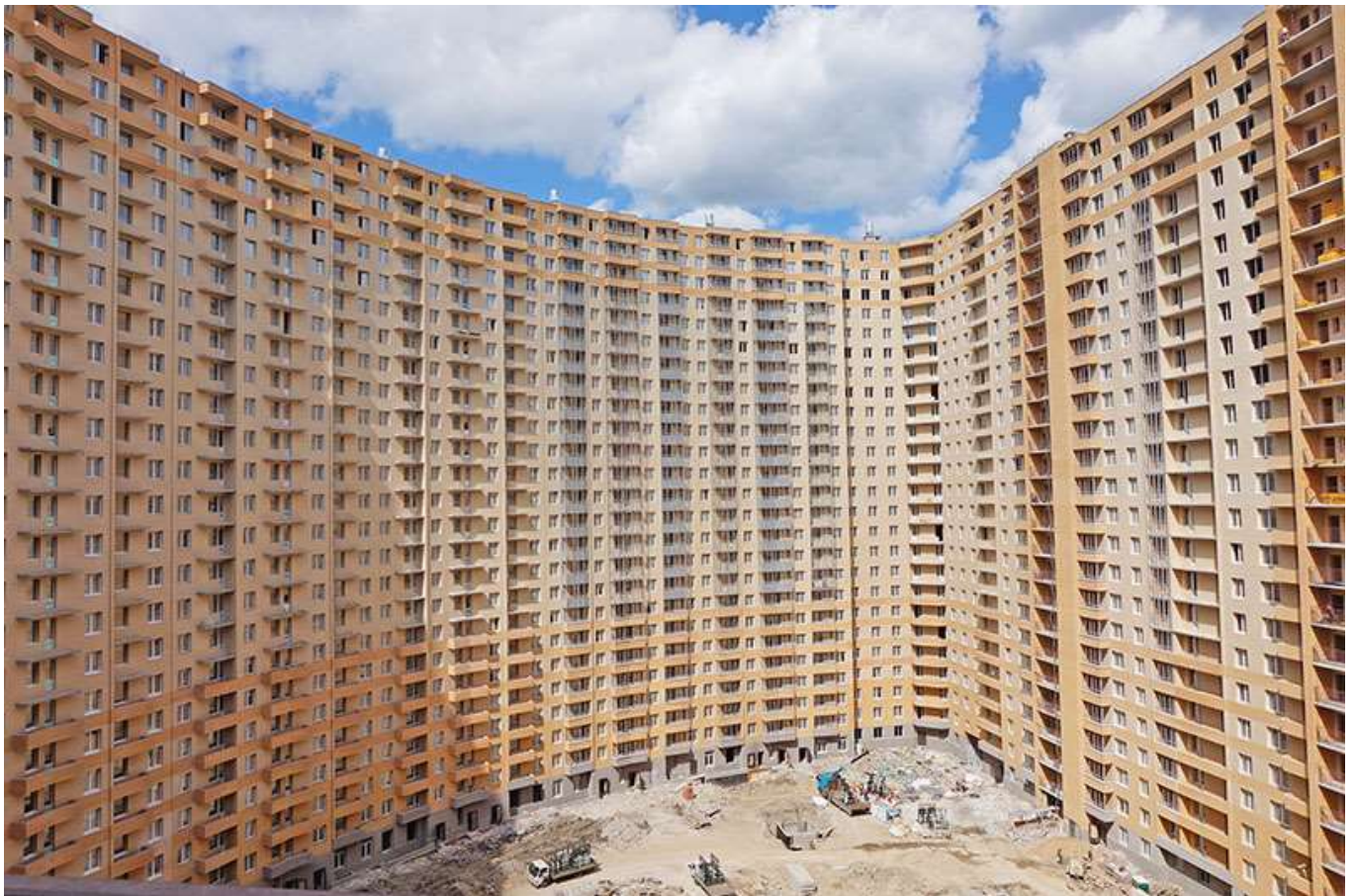
Вид на секции 3-10 со двора
