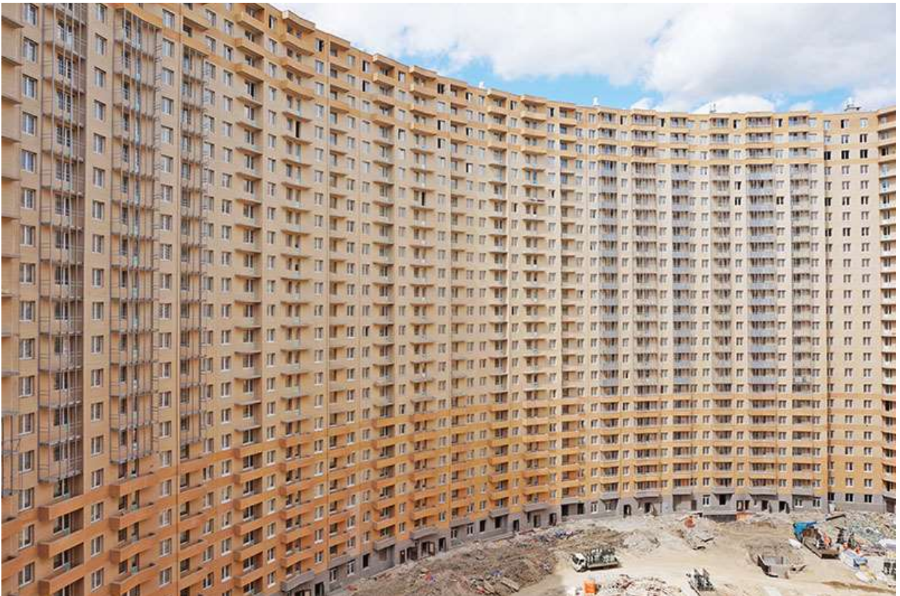
Вид на секции 2-8 со двора
