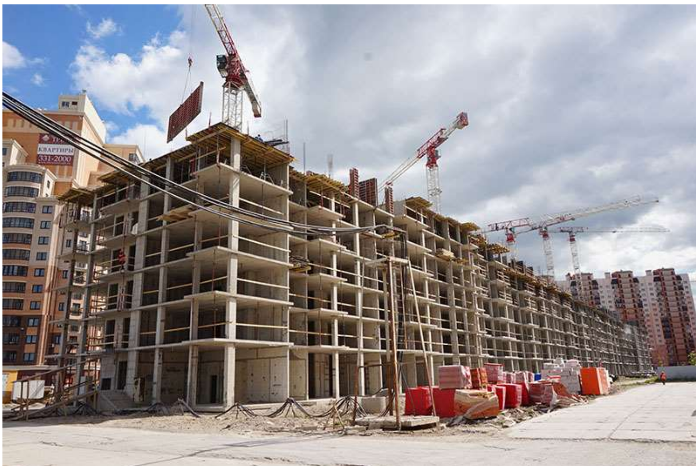
Вид на секции 9-1 со стороны Областной ул.
