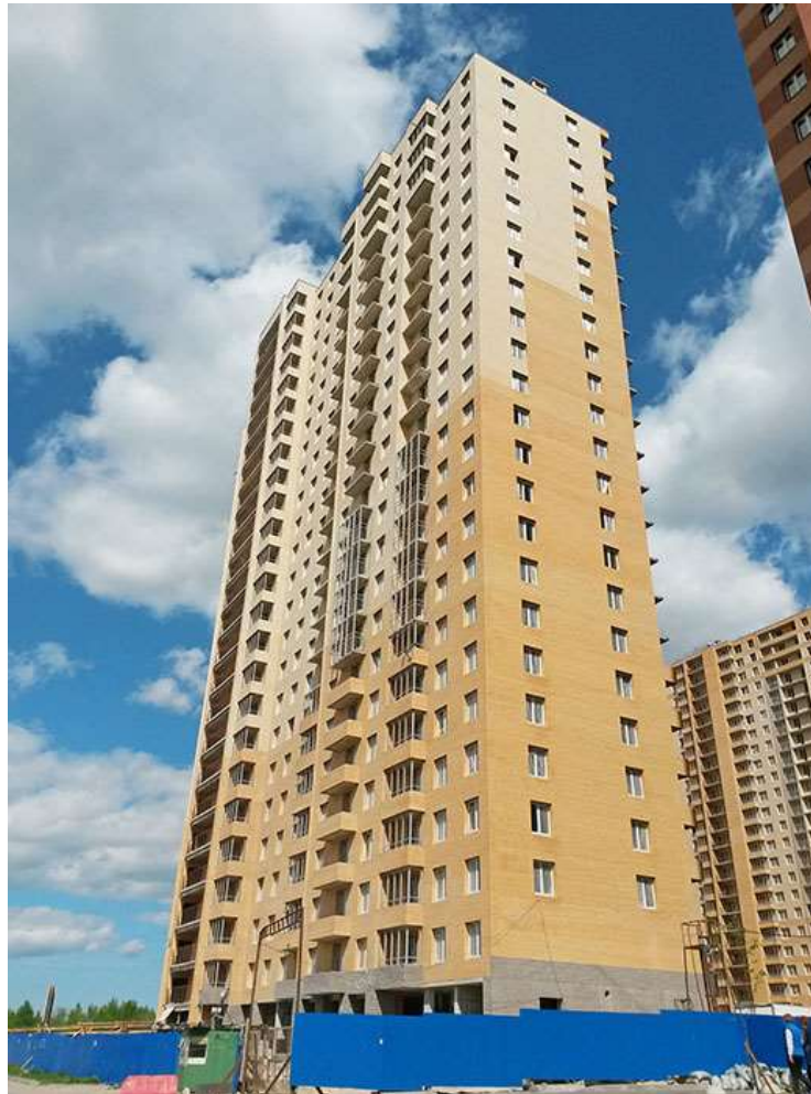
Вид на секции 1-2 со двора
