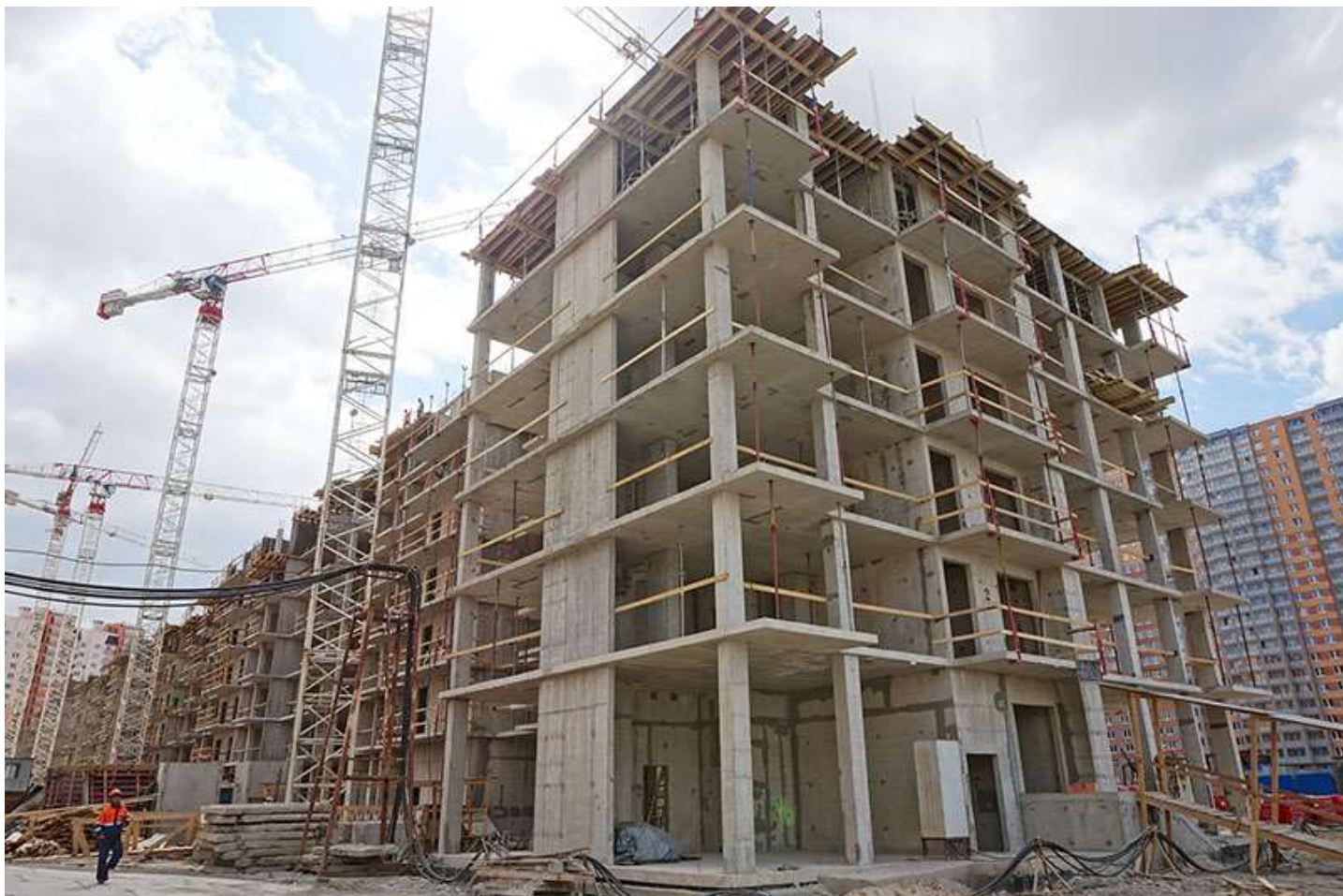
Вид на секцию 9 со стороны Областной ул.
