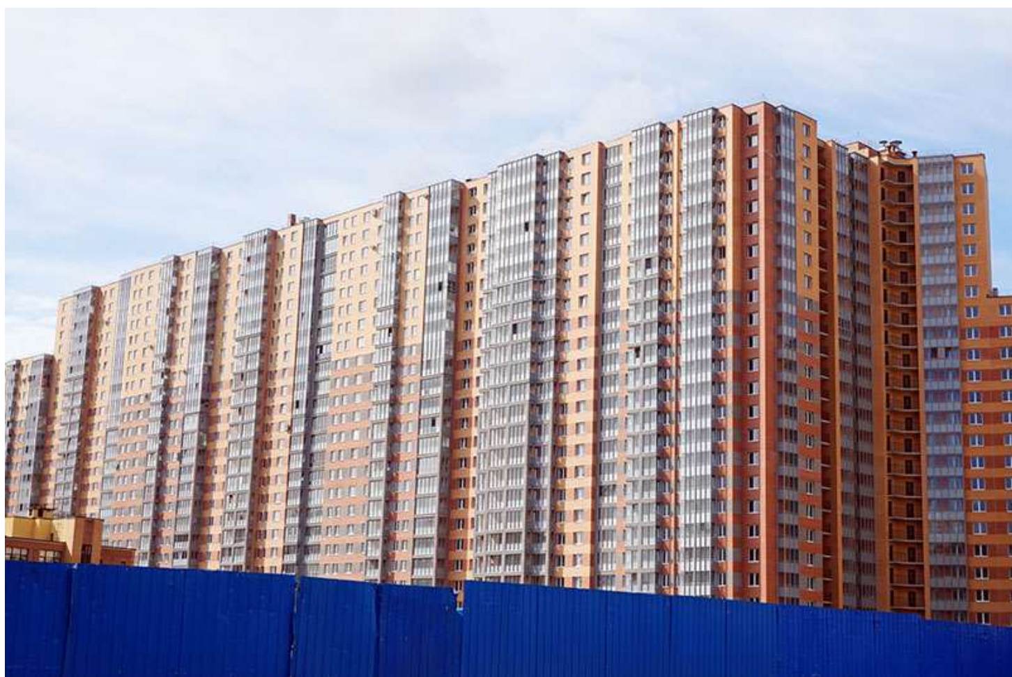
Вид с Областной улицы, секции 25-22
