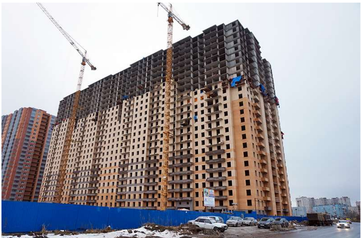
Вид на секции 11-8 со стороны Областной ул.
