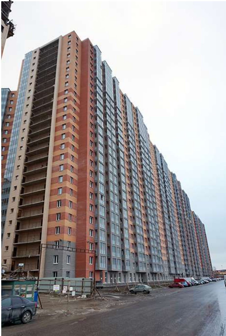
Вид со стороны Областной улицы, секции 20-15
