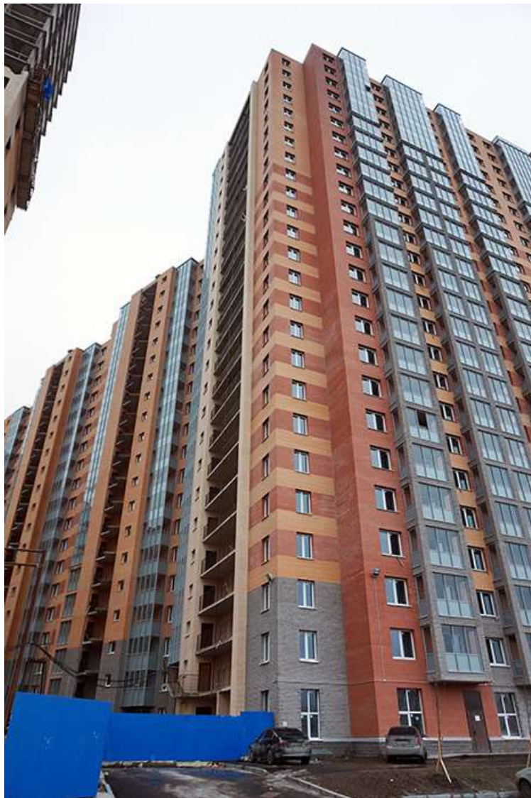
Вид со стороны Областной улицы, секции 22-19
