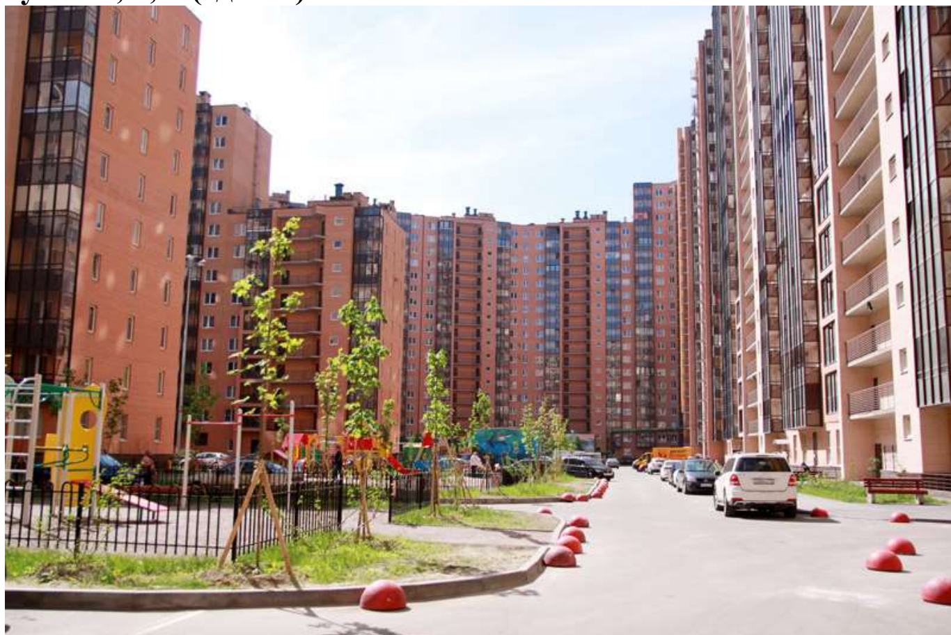
Благоустройство двора в 1-2-3-м пусках 3 очереди
