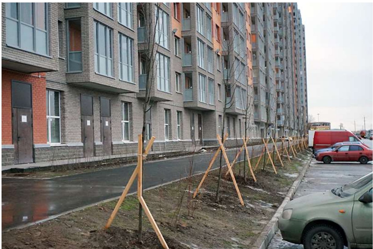
Вид со стороны Областной улицы, секции 19-18
