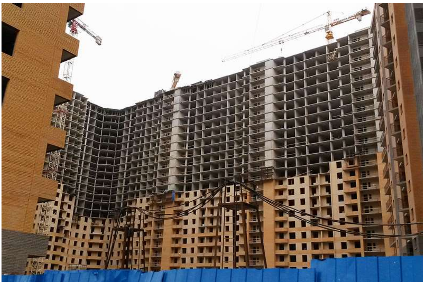
Вид на секции 7-11 с Областной ул.
