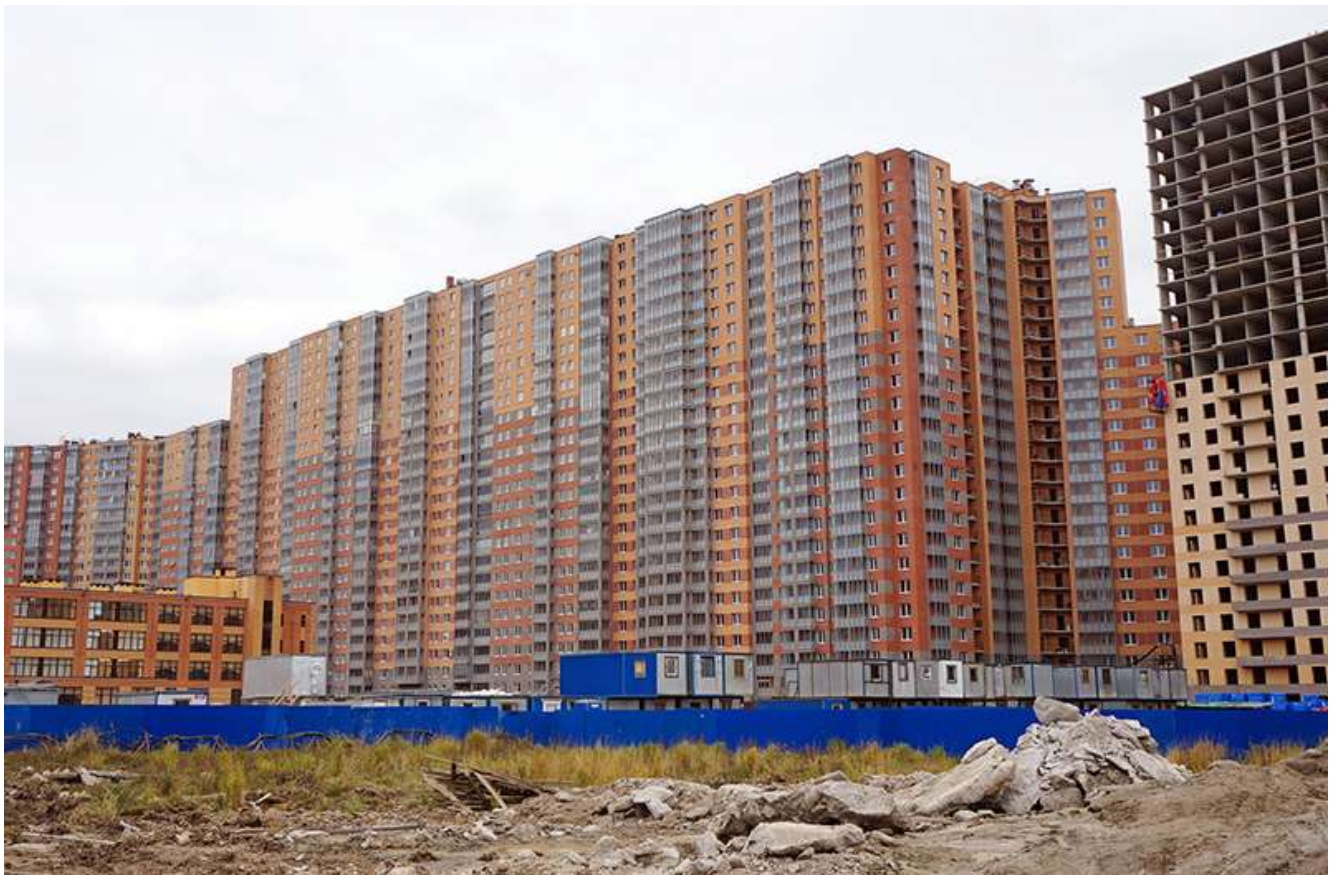
Вид с Областной улицы, секции 25-22
