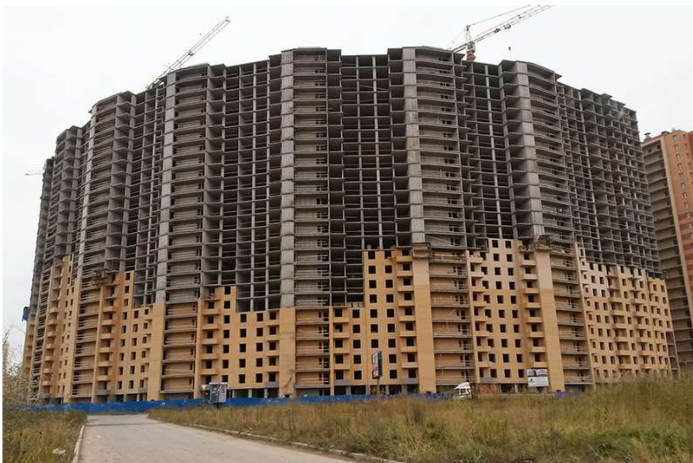
Вид на секции 7-1 с Областной ул.
