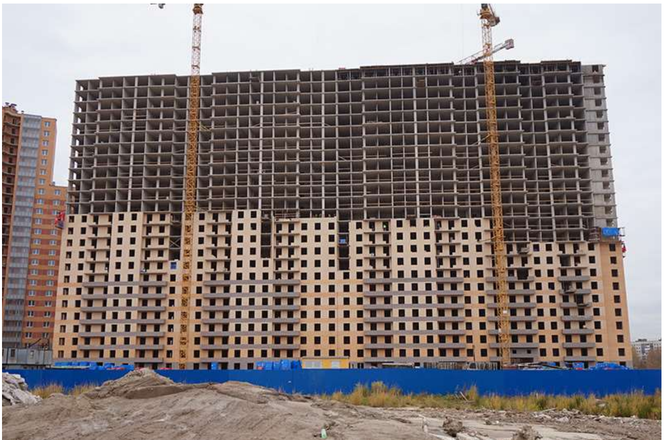
Вид на секции 11-8 со стороны Областной ул.
