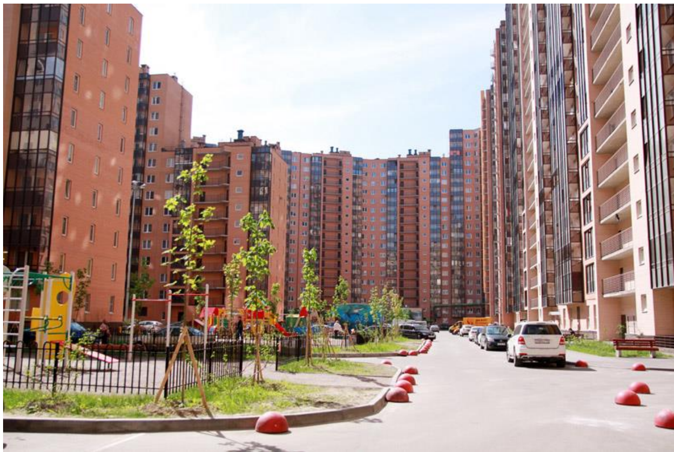
Благоустройство двора в 1-2-3-м пусках 3 очереди
