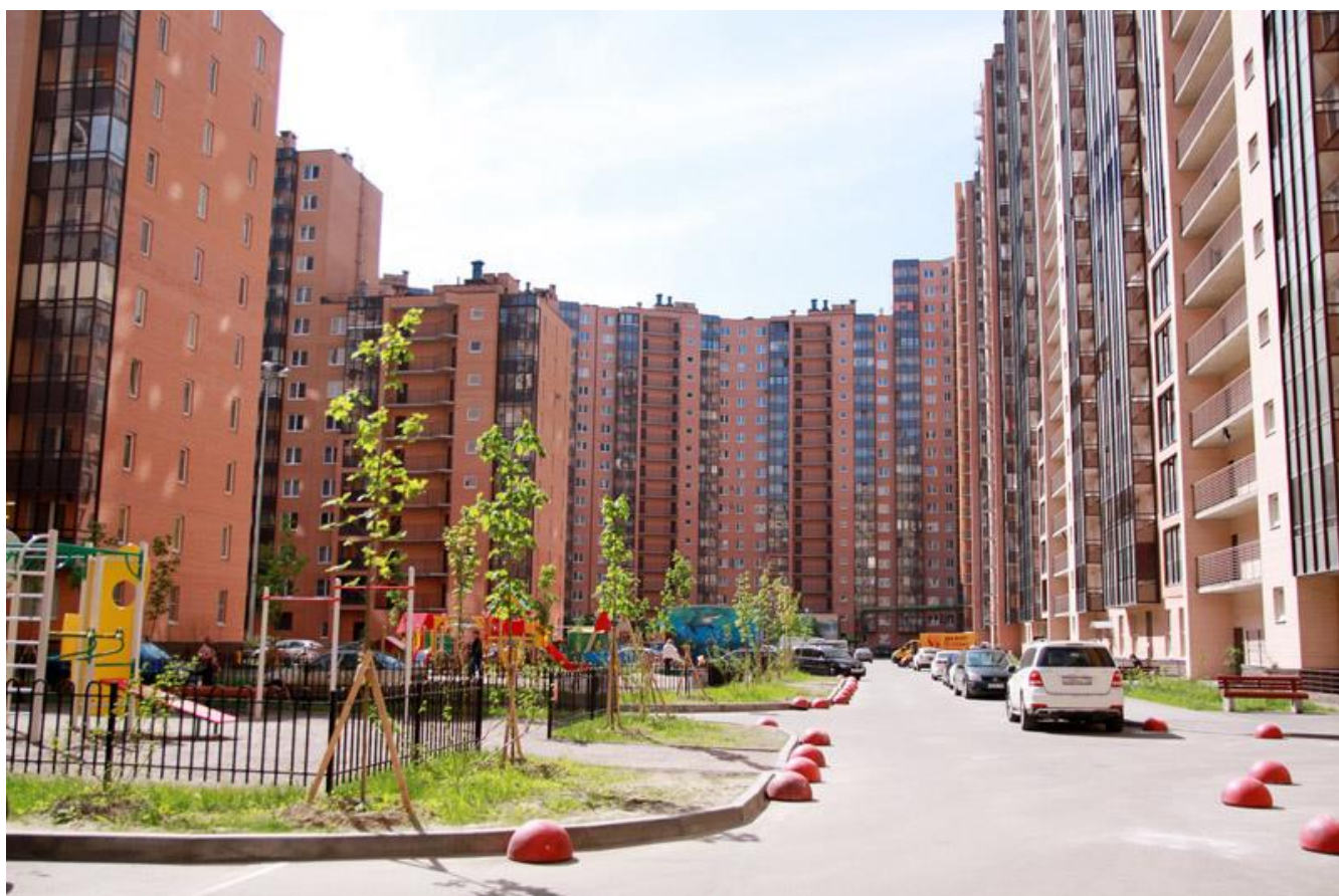
Благоустройство двора в 1-2-3-м пусках 3 очереди
