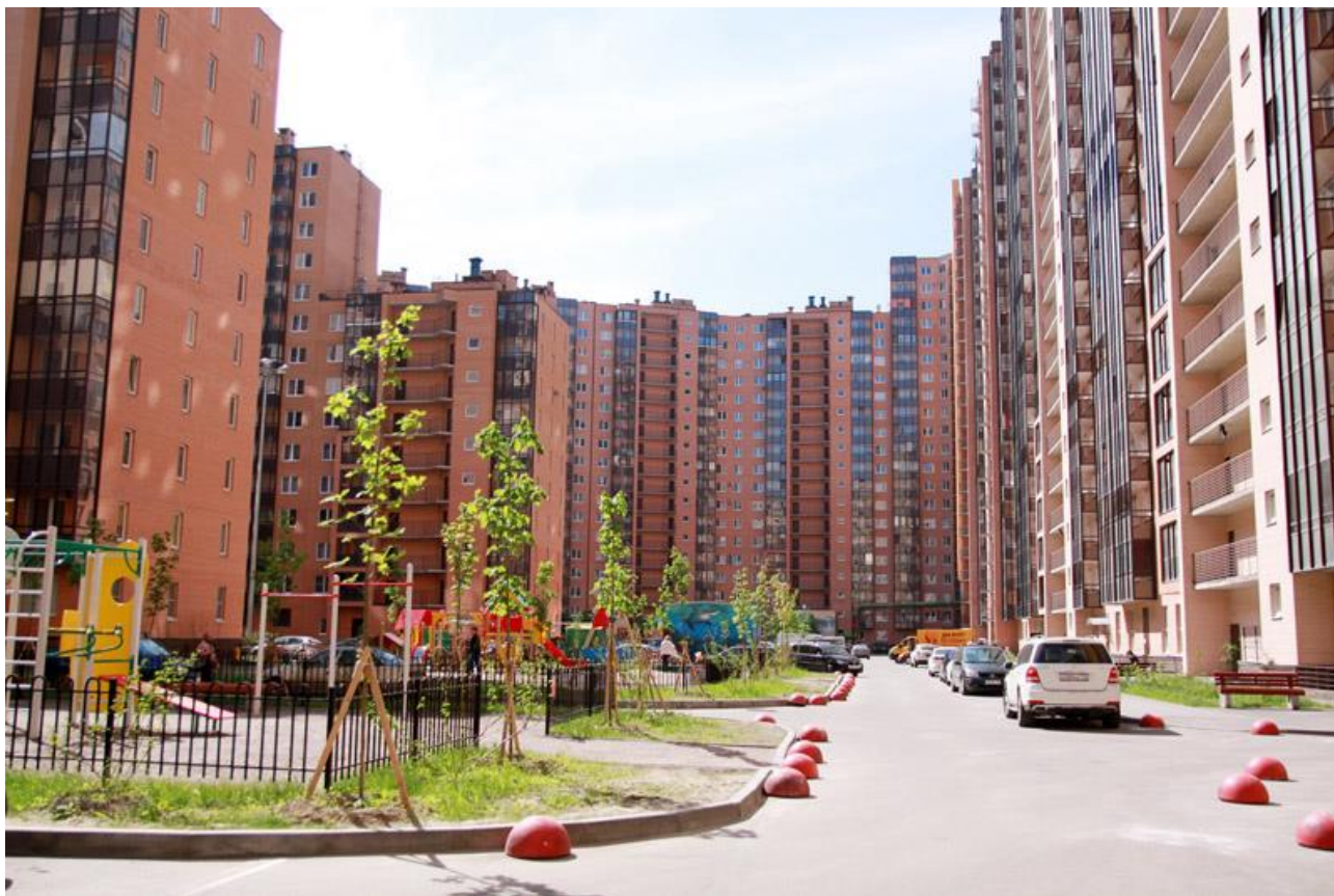
Благоустройство двора в 1-2-3-м пусках 3 очереди
