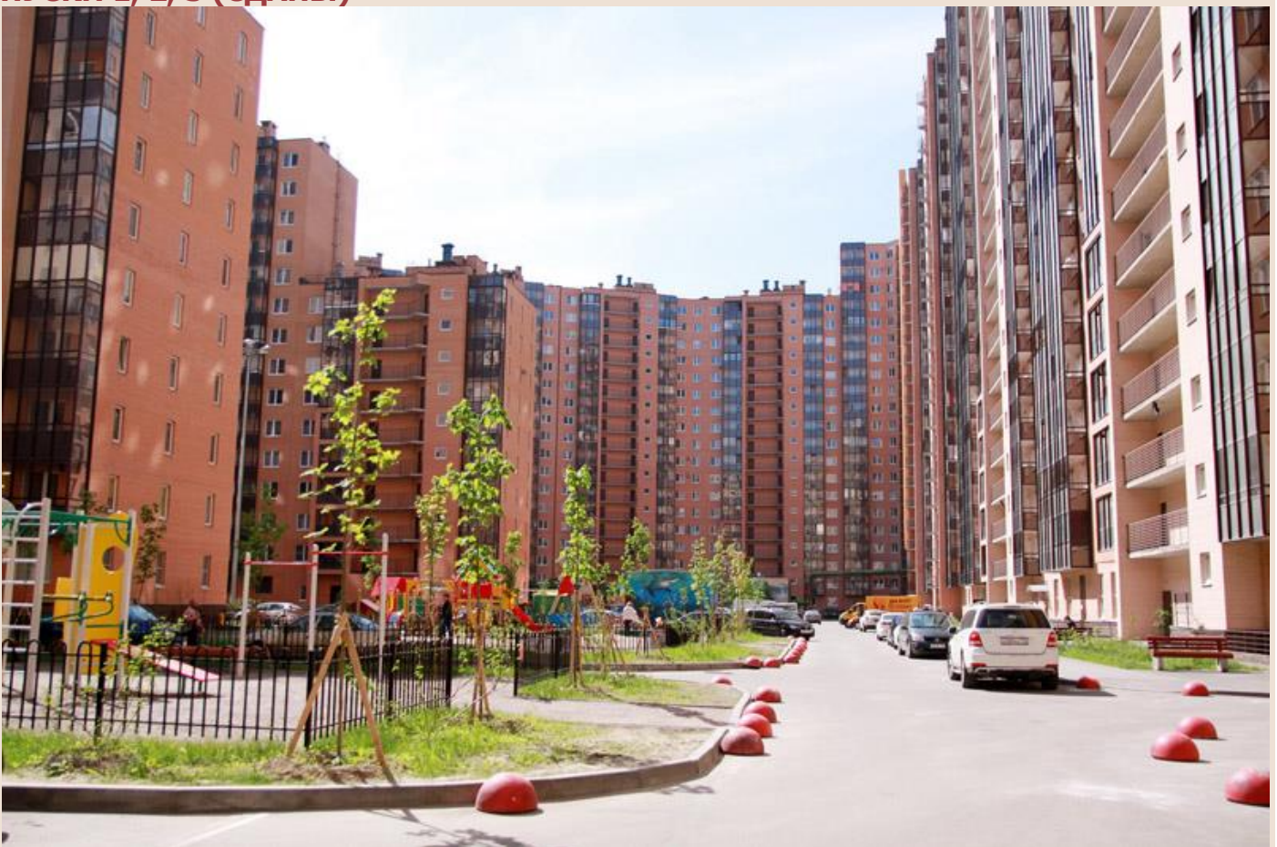
Благоустройство двора в 1-2-3-м пусках 3 очереди
