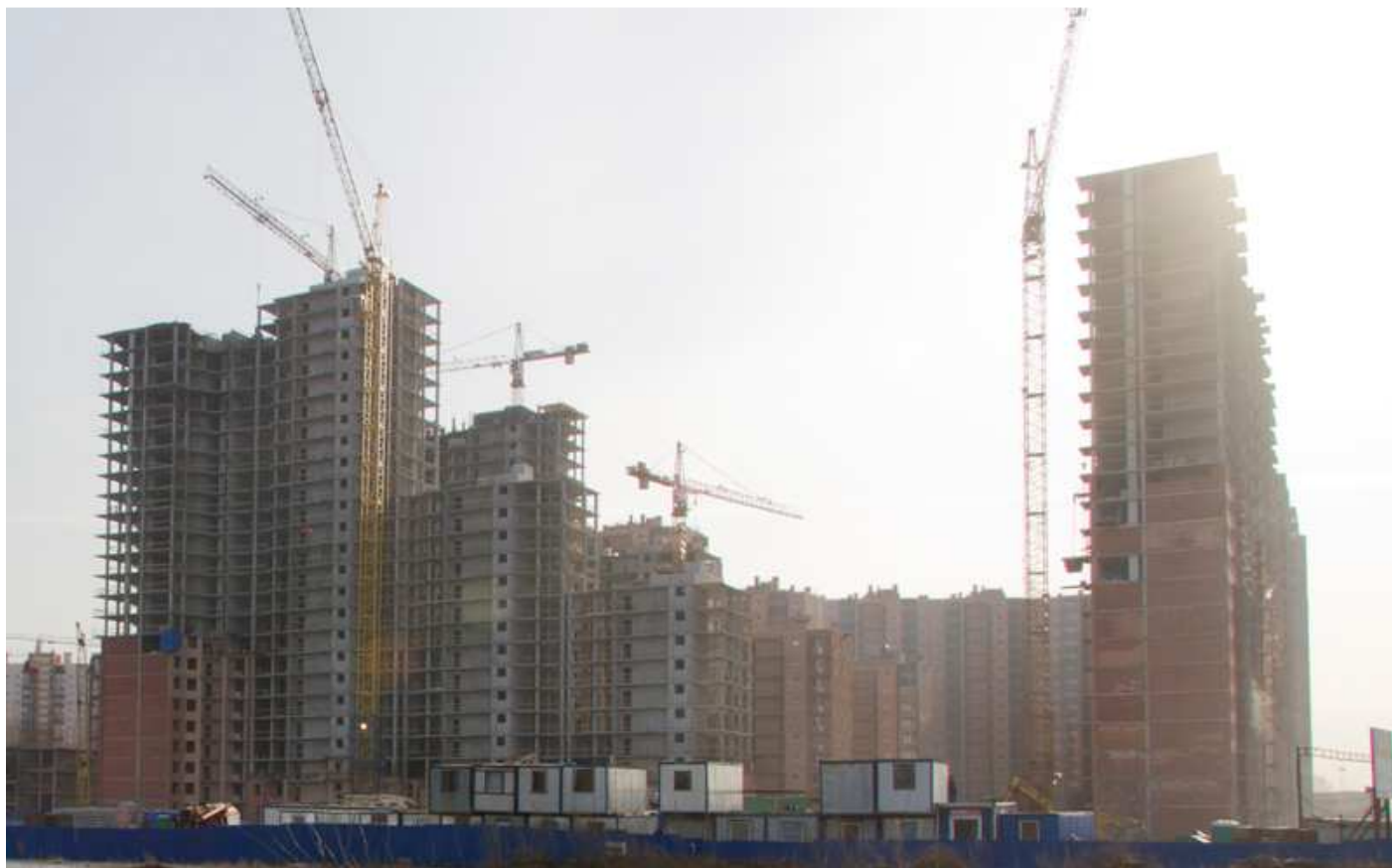
Вид с Областной улицы на секции 29-26, 15-17 со двора
