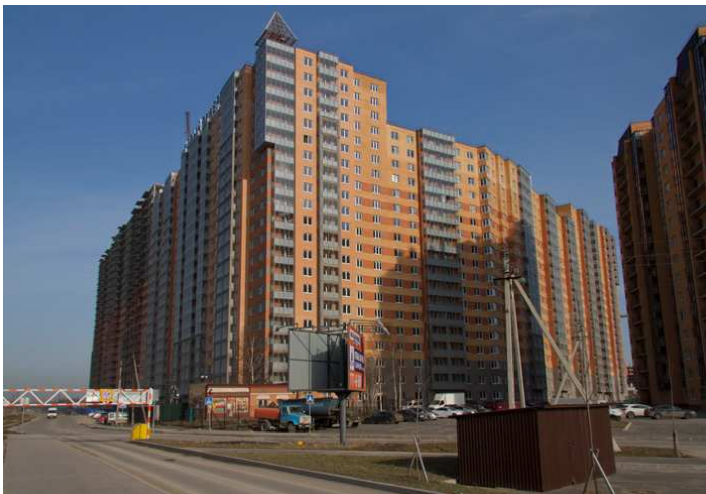
Вид с Областной улицы на секции (слева направо) 17-7
