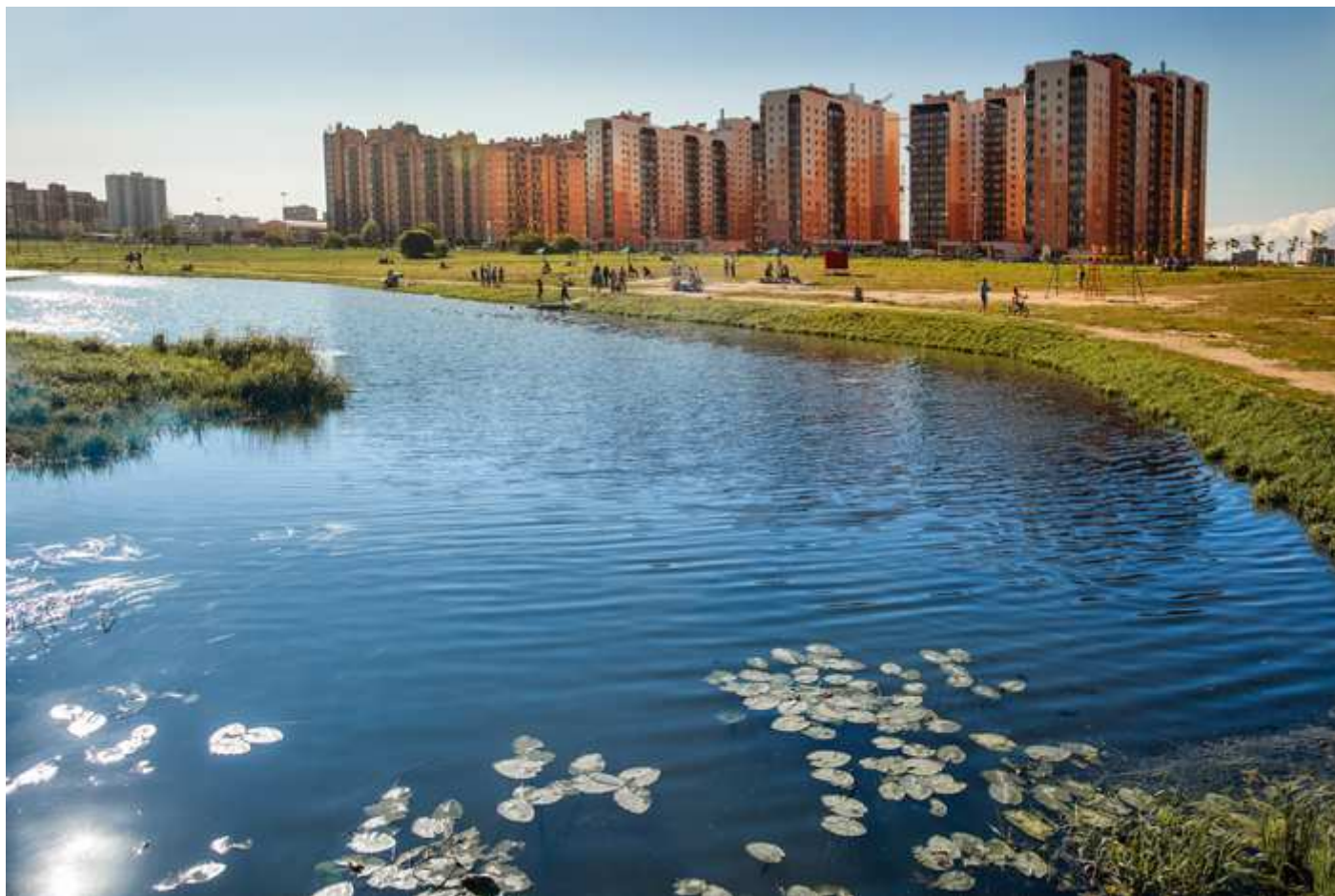
Парк с пешеходными и велодорожками. Фото от 22.07.2012
