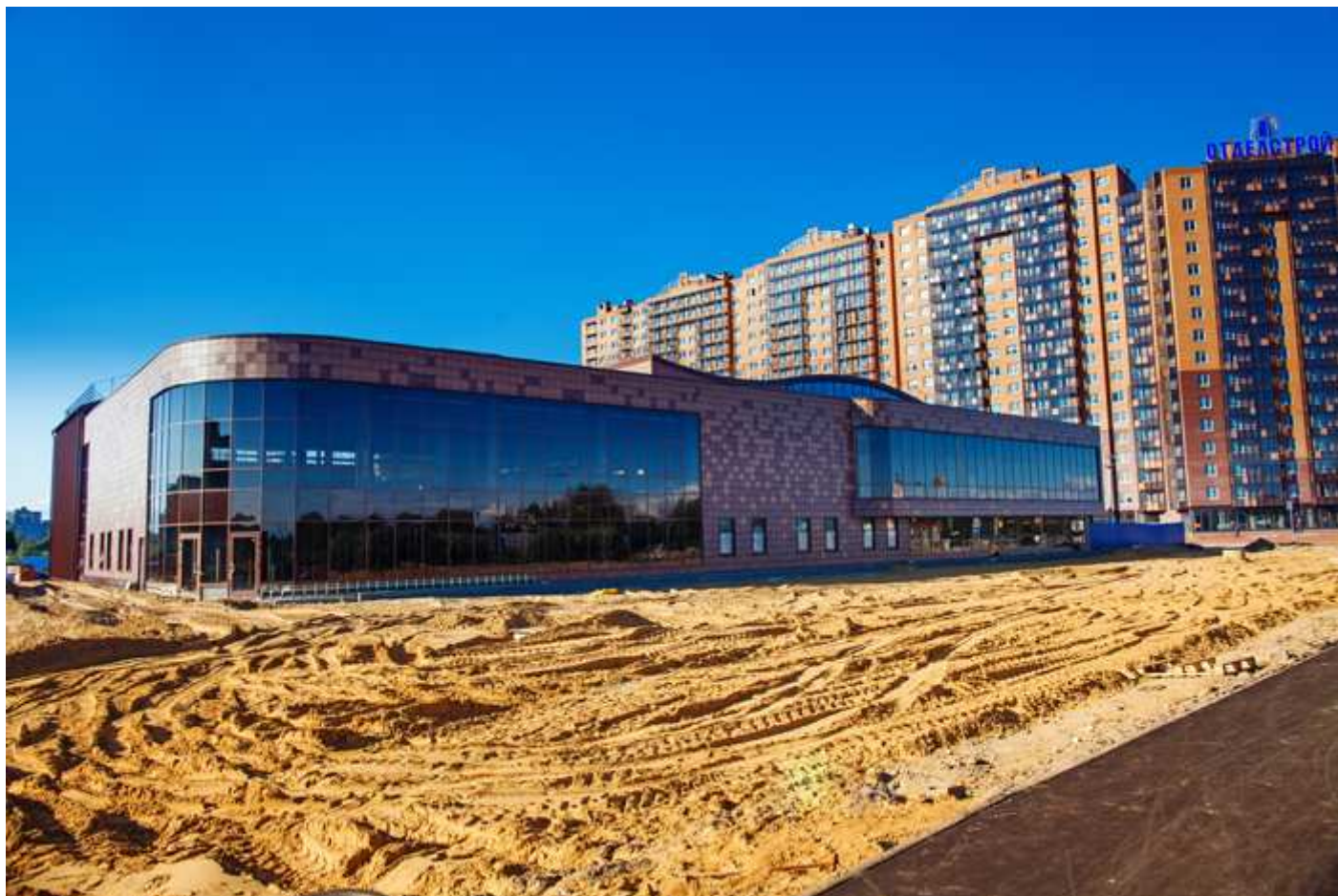
Строится спортивный комплекс. Фото от 22.07.2012
