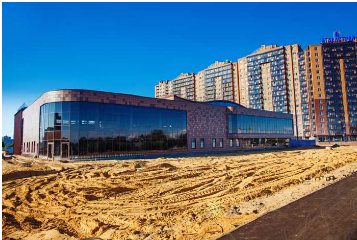
Строится спортивный комплекс. Фото от 22.07.2012
