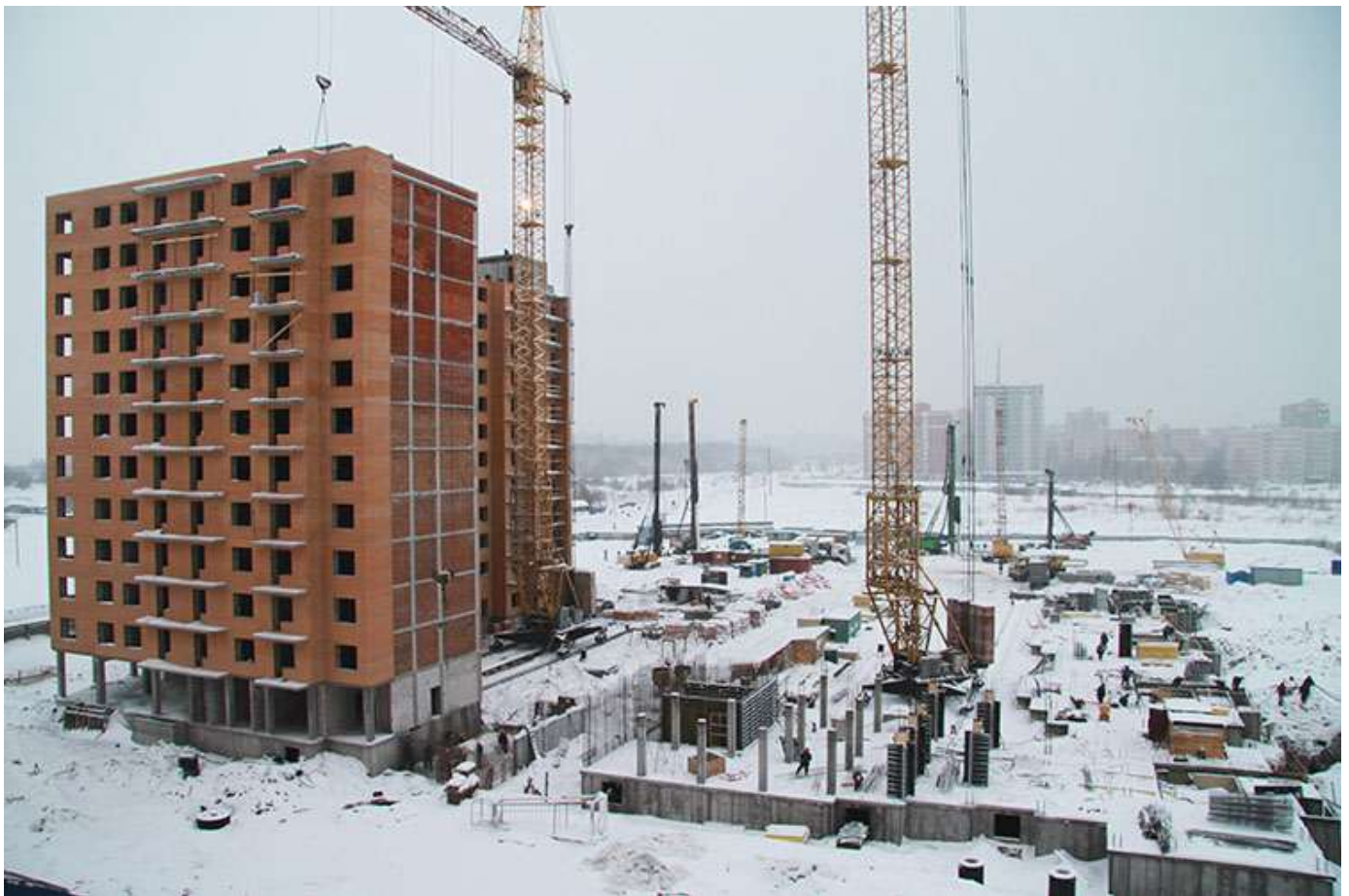
Строительство детского сада, фото 25.01.2011
