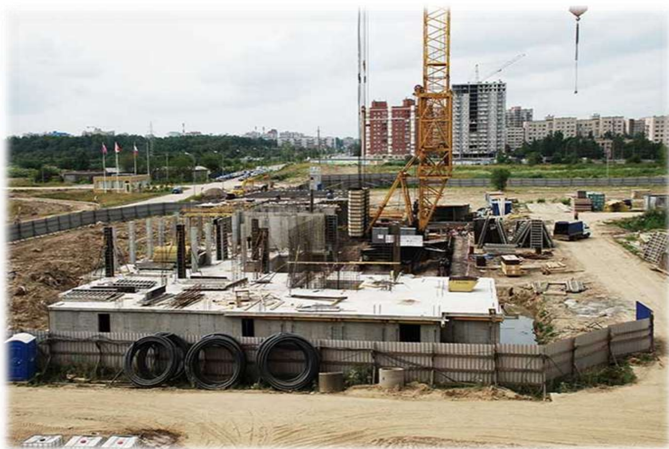
Фотография от 19.07.2010 (II-я оч. строительства)
