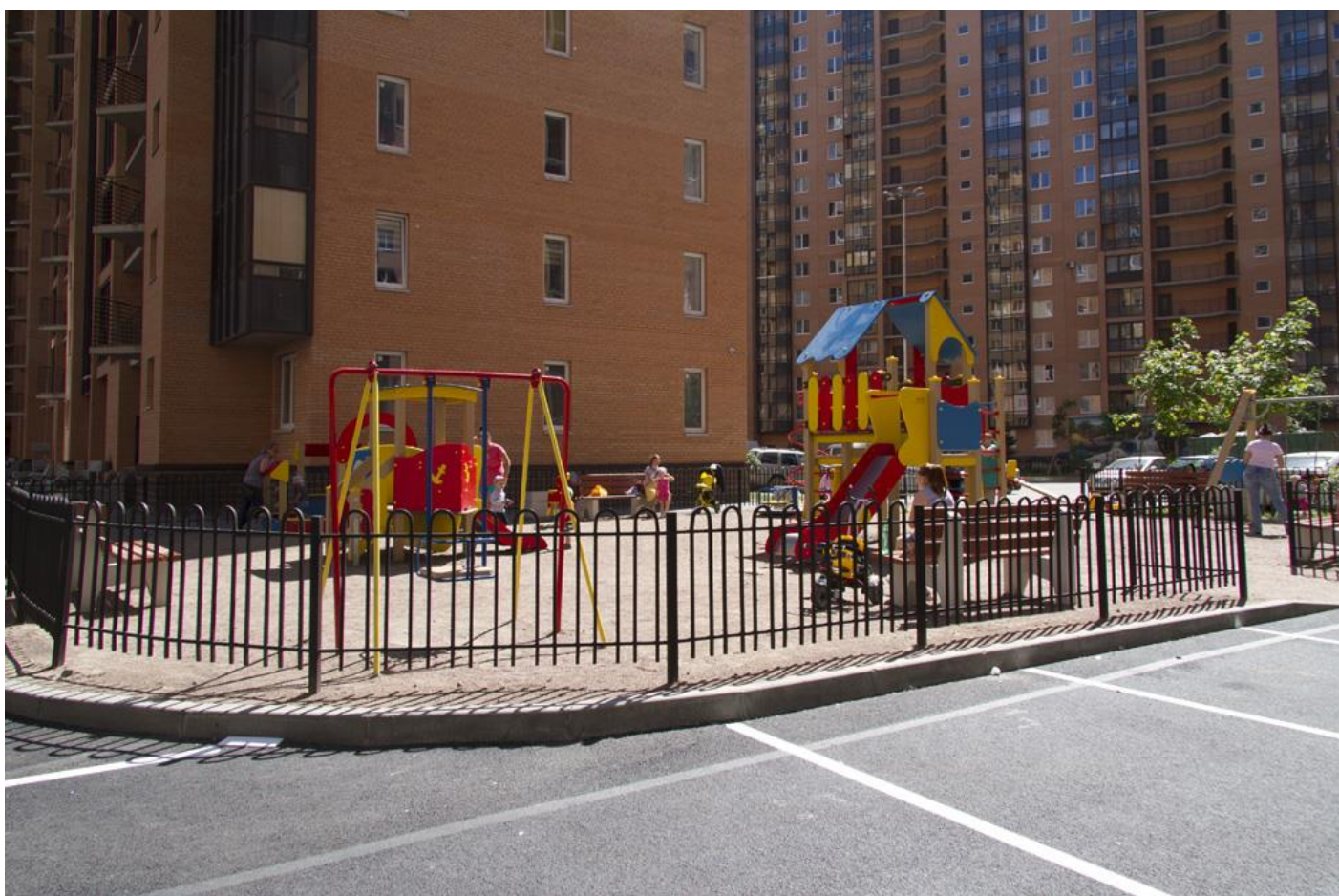
Благоустройство двора в 1-2-м пусках 3 очереди
