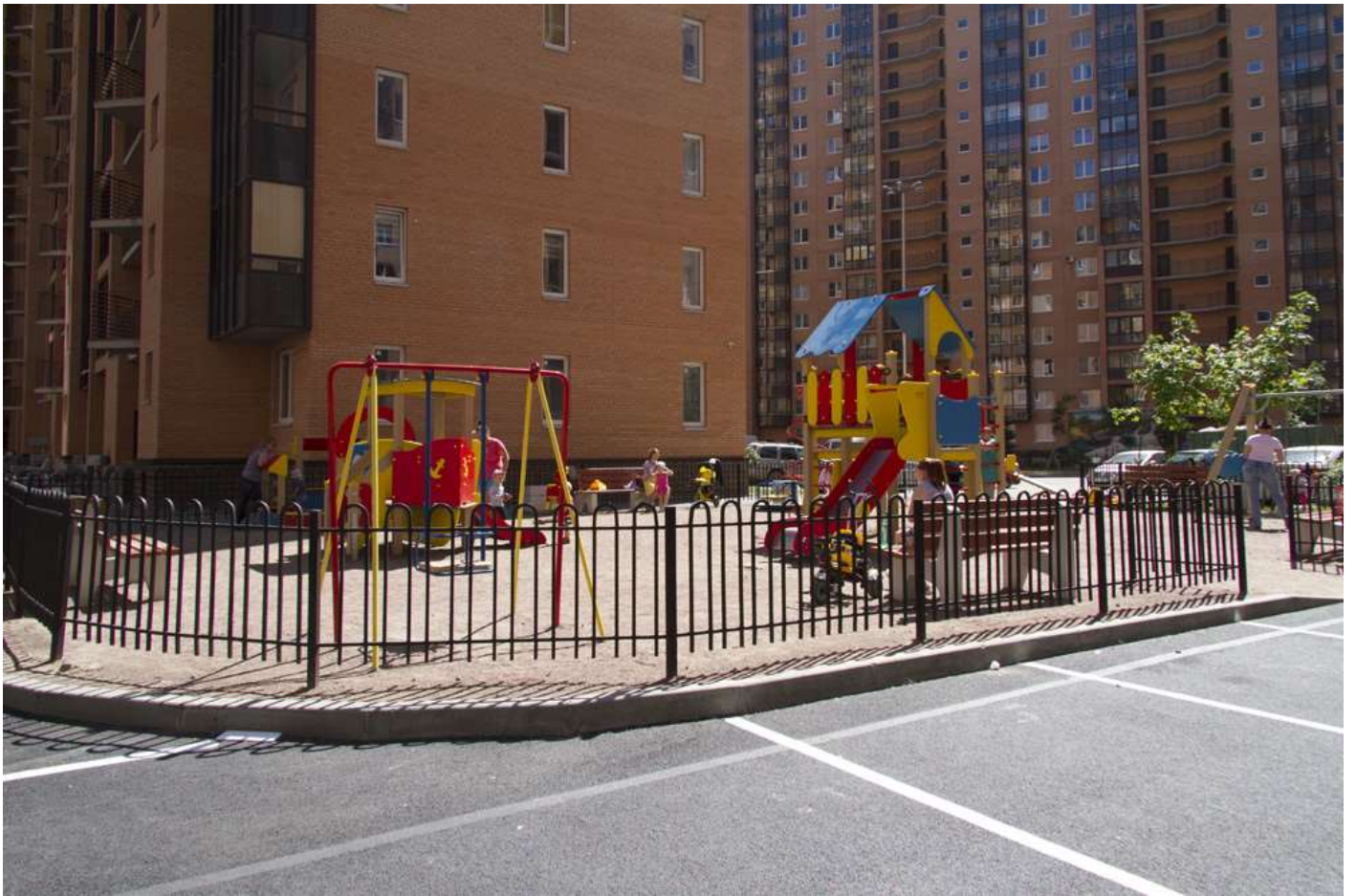
Благоустройство двора в 1-2-м пусках 3 очереди
