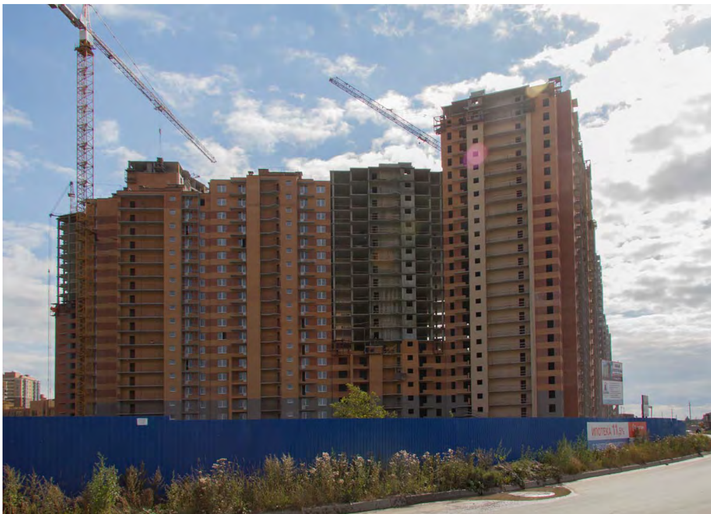
Вид со стороны Областной ул., секции 24-12
