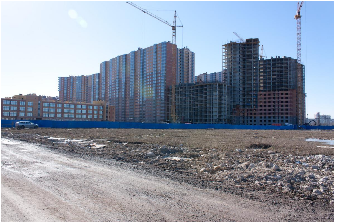
Вид со стороны Областной ул., секции 6-4, 35-34, 30-26, 25-22
