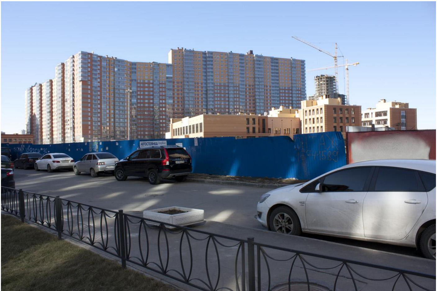
Вид на 3 очередь и школу со стороны 1 очереди
