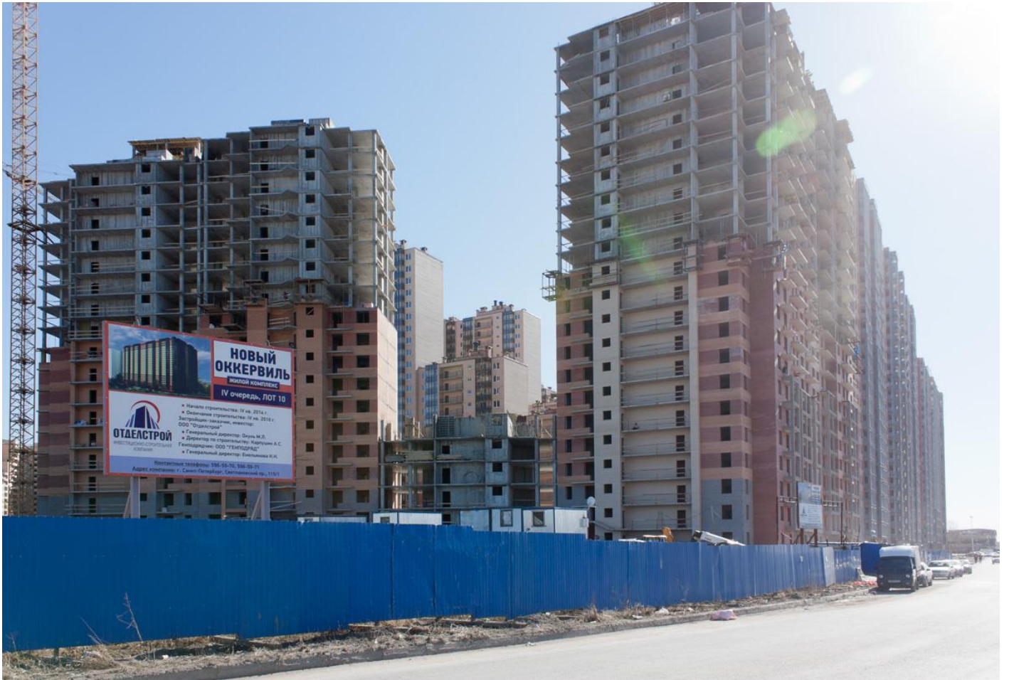
Вид со стороны Областной ул., секции 24-12
