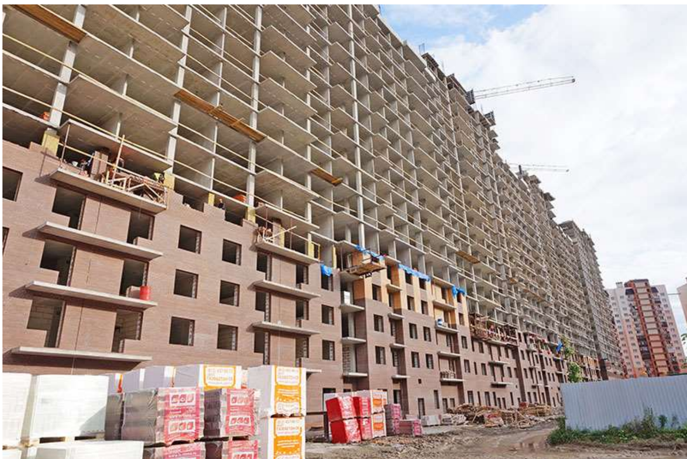
Вид на секции 6-1 со стороны Берёзовой ул.
