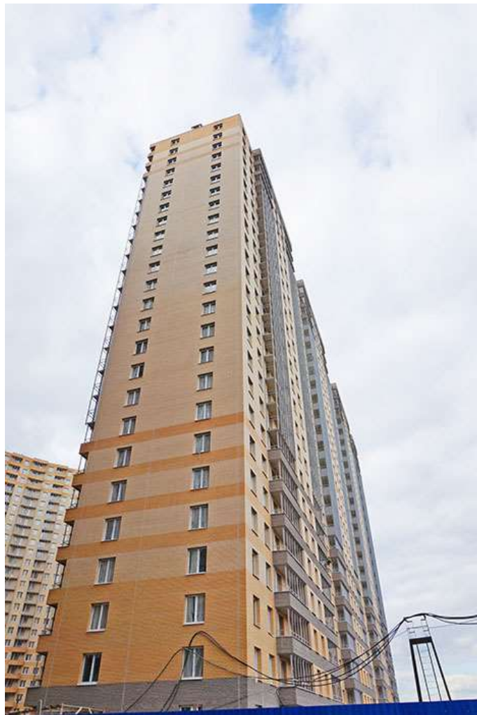
Вид на секции 11-9 со стороны Берёзовой ул.
