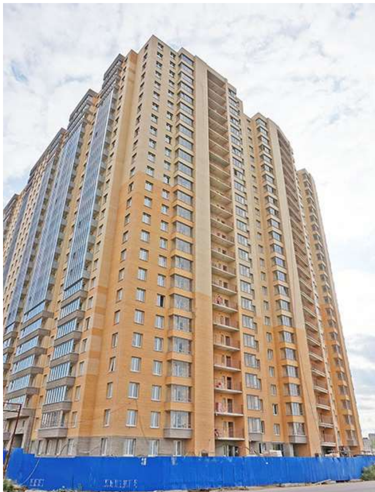
Вид на секции 8-7 со стороны Областной ул.
