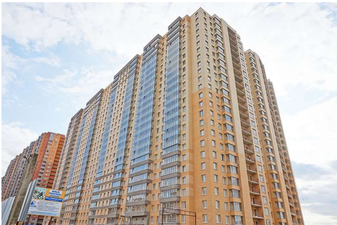
Вид на секции 11-7 со стороны Областной ул.
