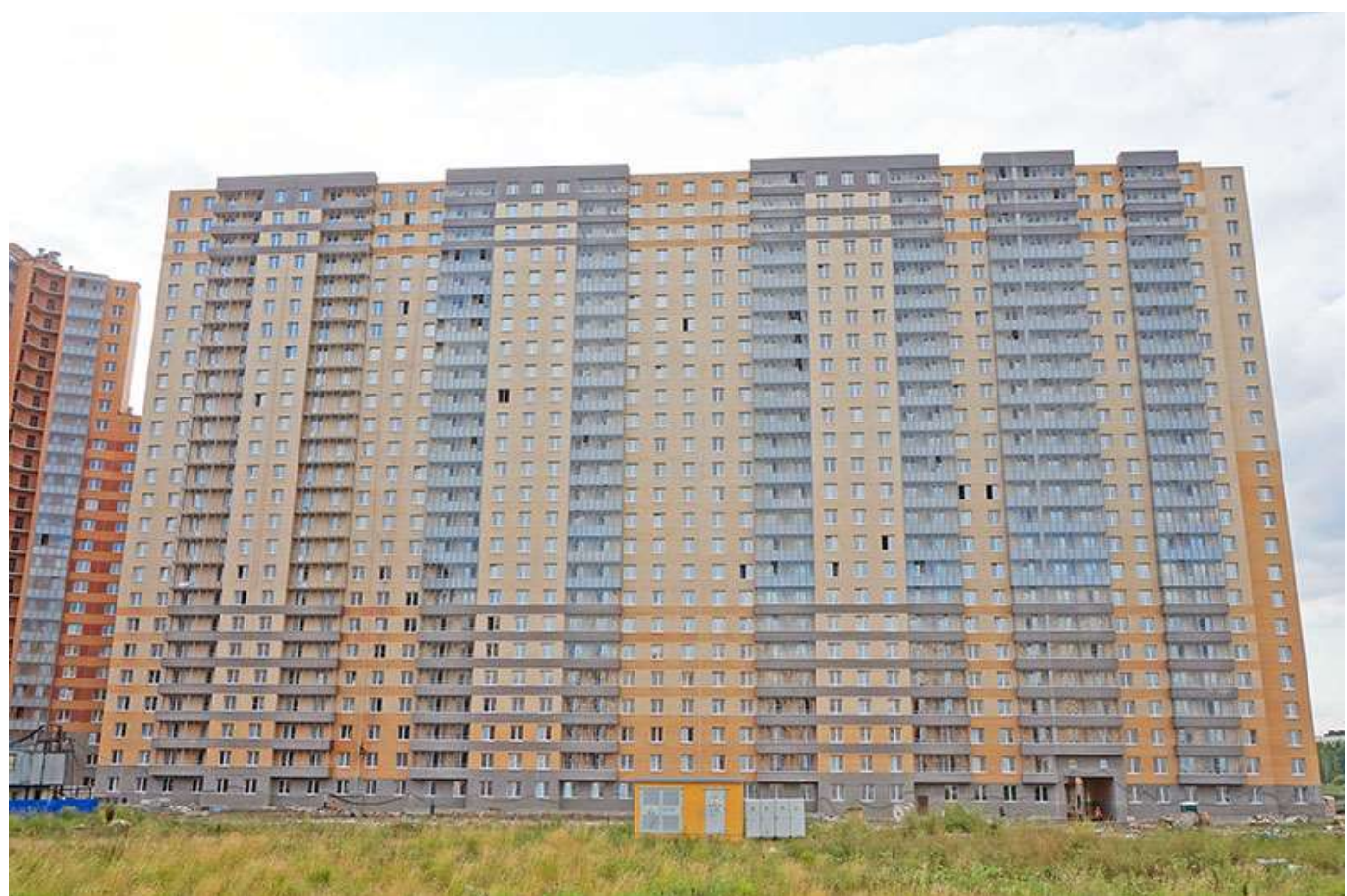
Вид на секции 11-8 со стороны Берёзовой ул.
