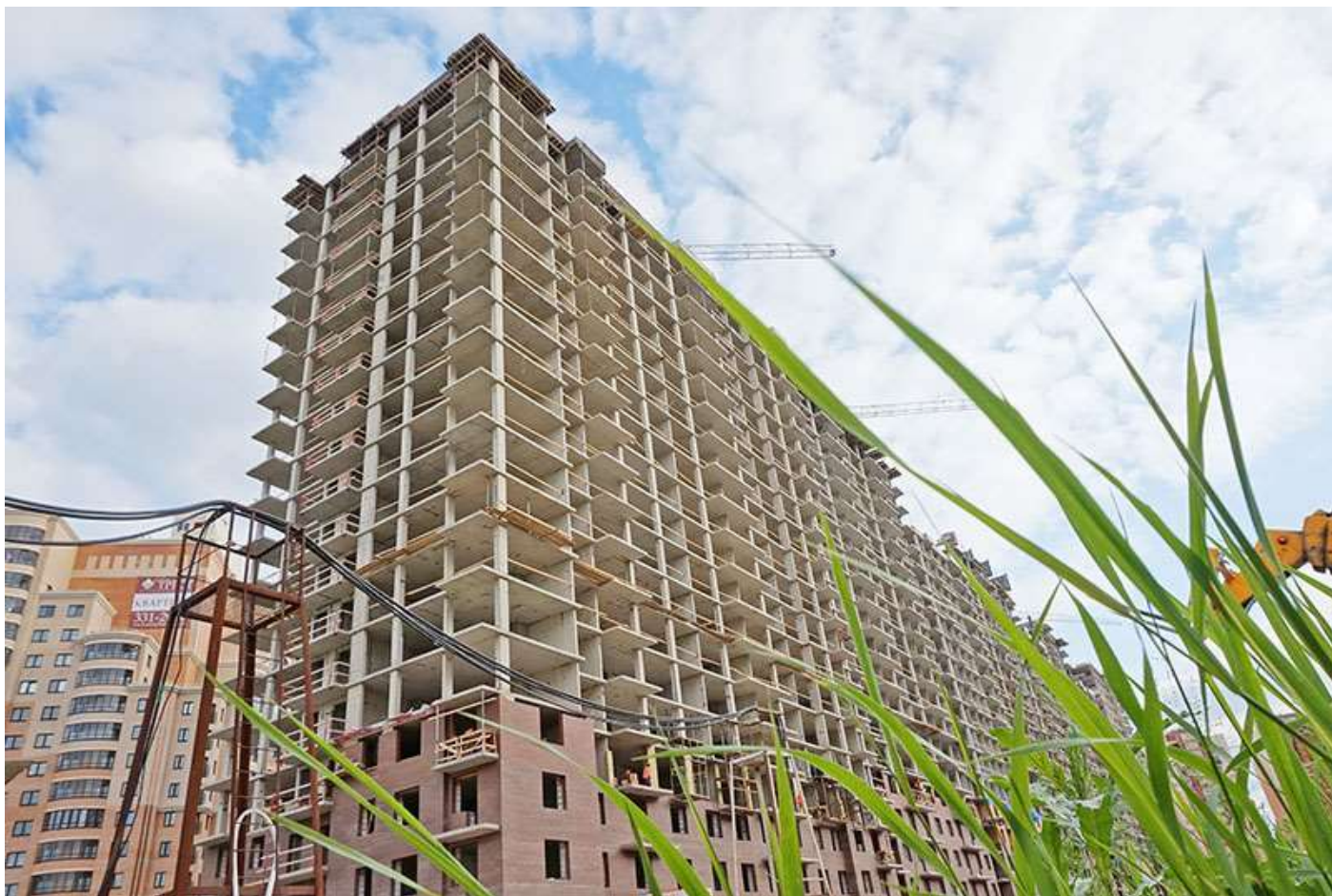
Вид на секции 9-1 со стороны Областной ул.
