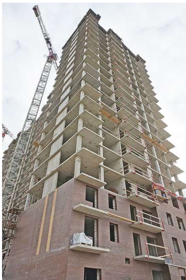
Вид на секцию 1 со стороны Областной ул.
