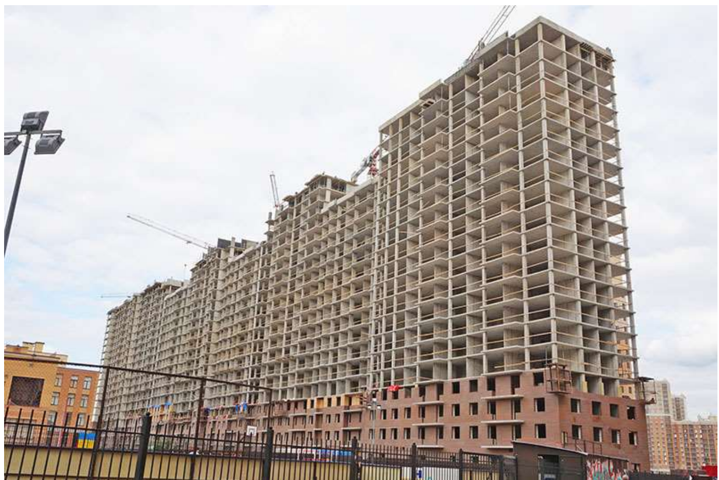
Вид на секции 1-9 со стороны Ленинградской ул.
