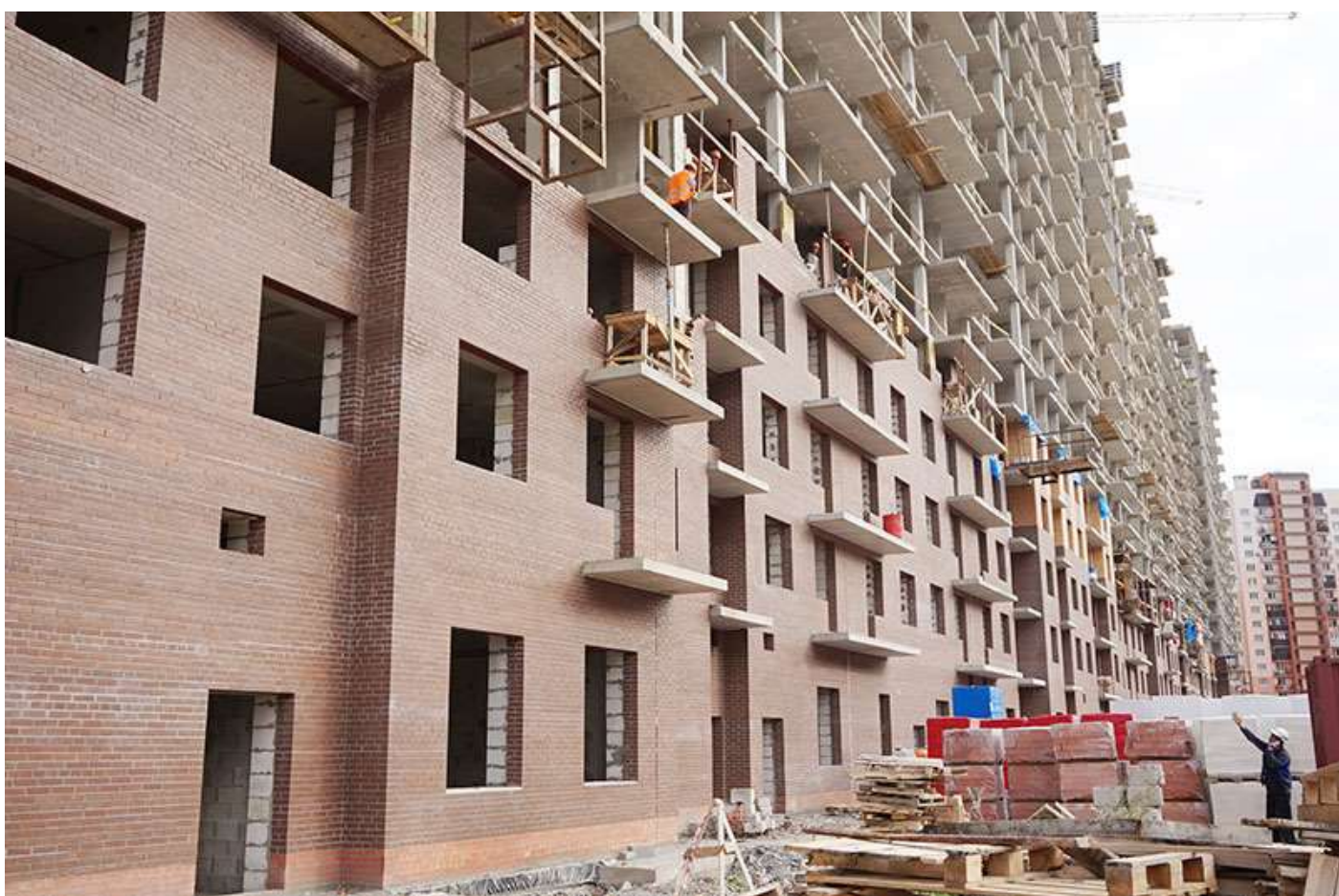
Вид на секции 7-6 со стороны Берёзовой ул.
