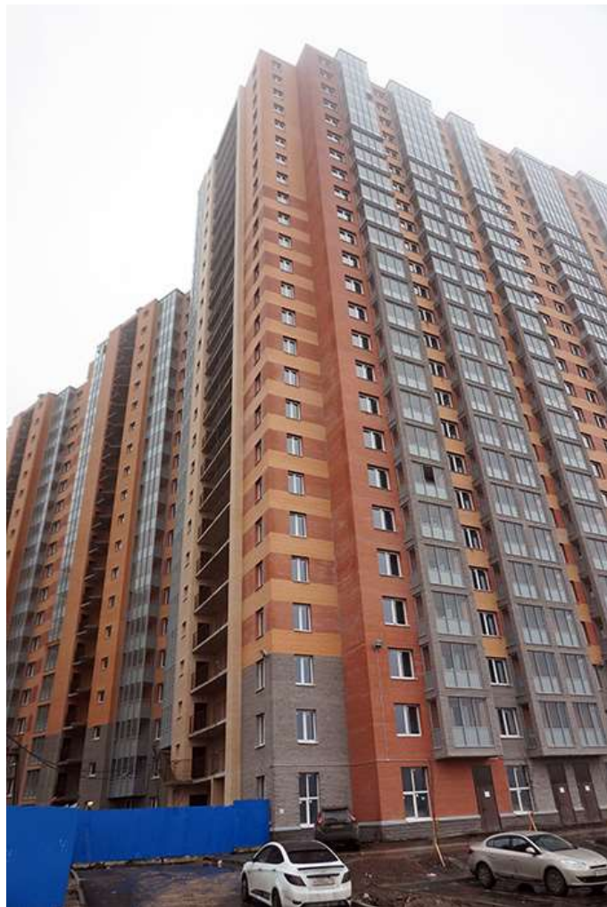
Вид со стороны Областной улицы, секции 22-19
