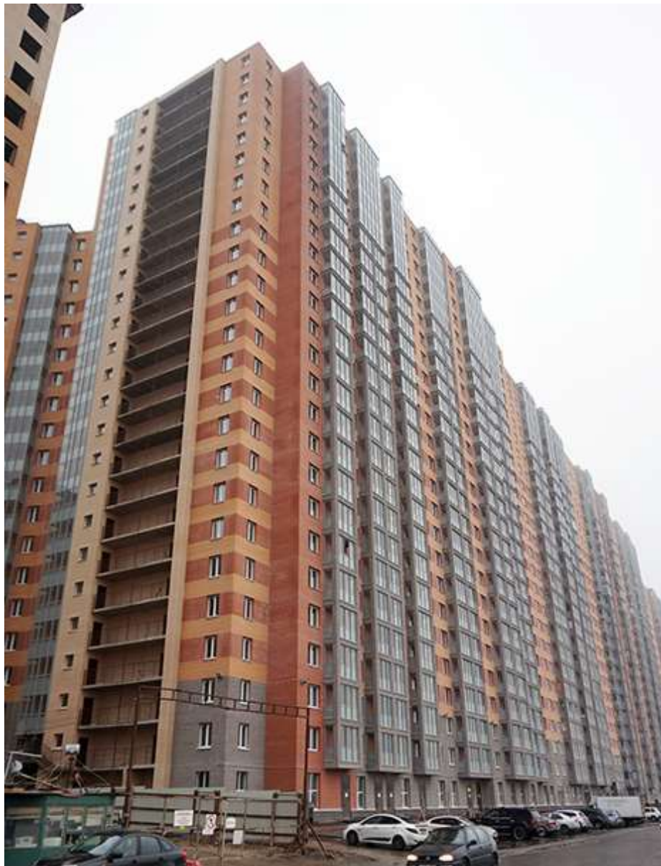
Вид со стороны Областной улицы, секции 20-15
