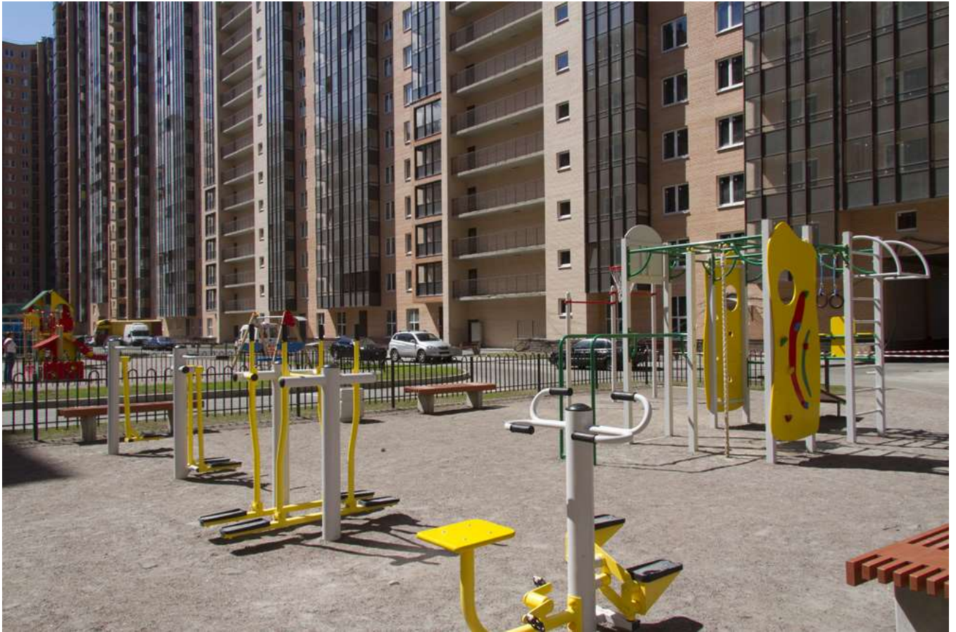
Благоустройство двора в 3-м пуске 3 очереди
