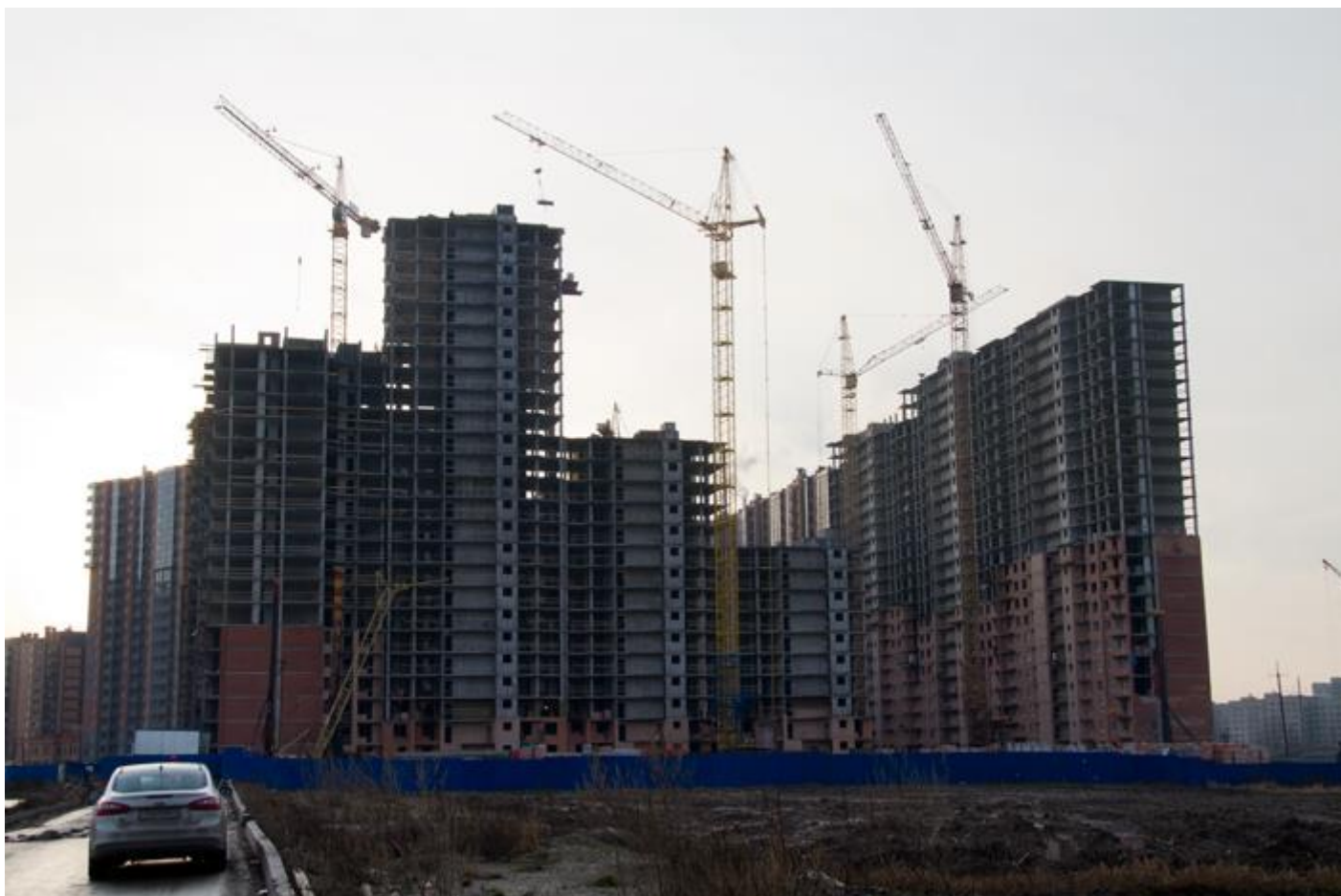
Вид с Областной улицы на секции 29-26, 15-17 со двора
