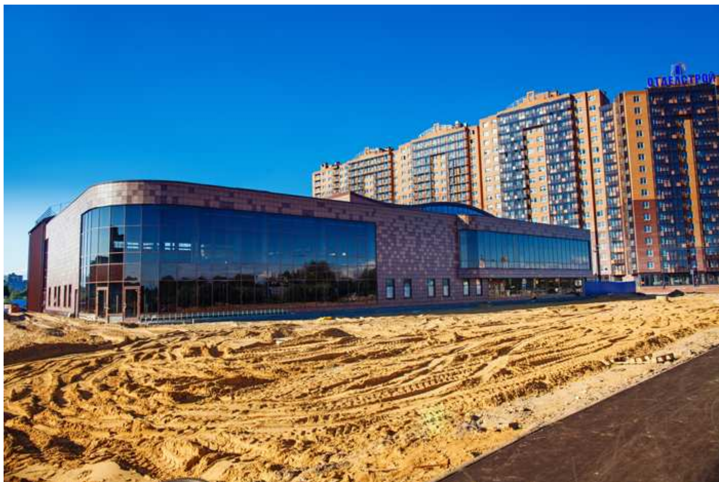
Строится спортивный комплекс. Фото от 22.07.2012
