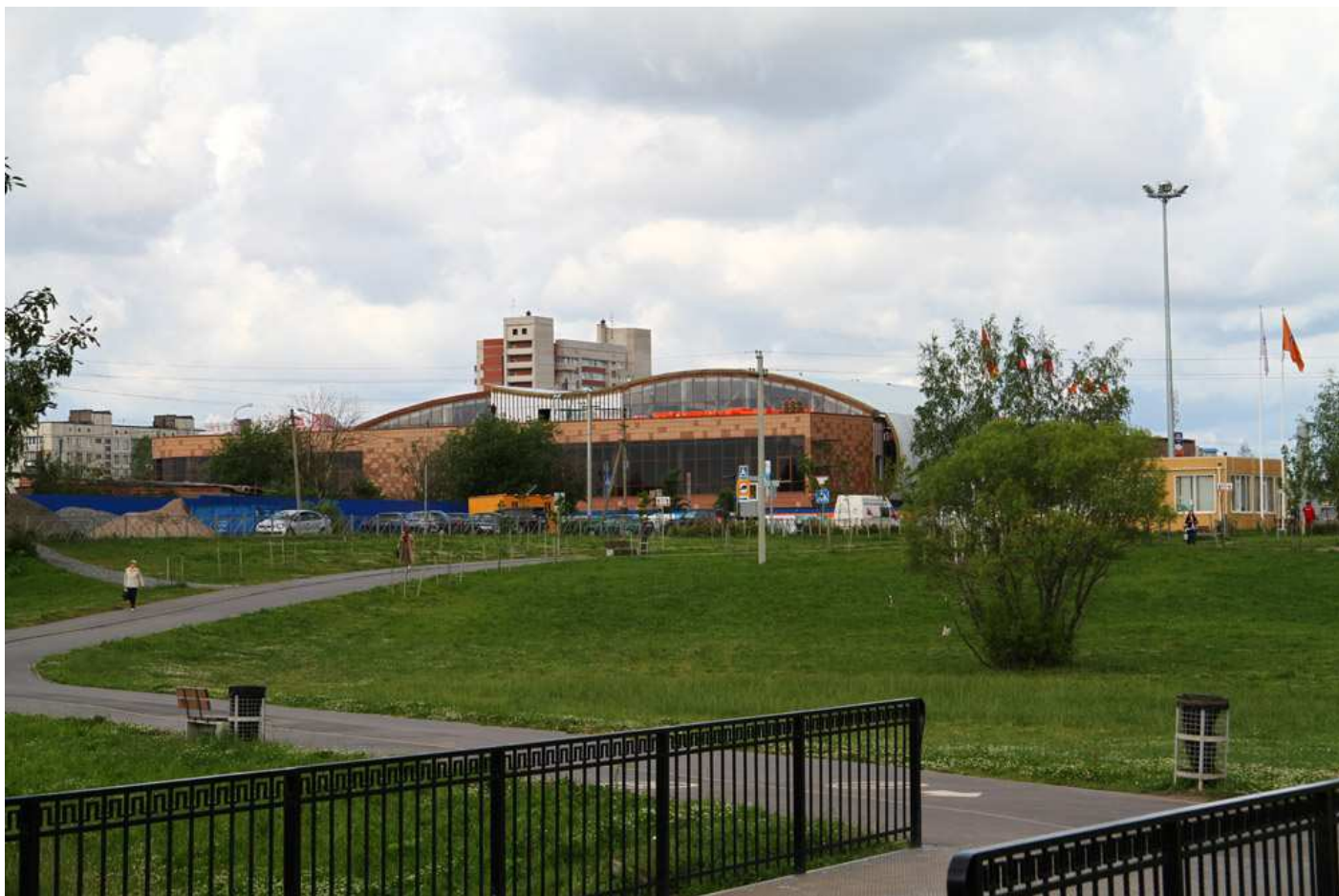
Строится спортивный комплекс. Фото от 29.06.2012
