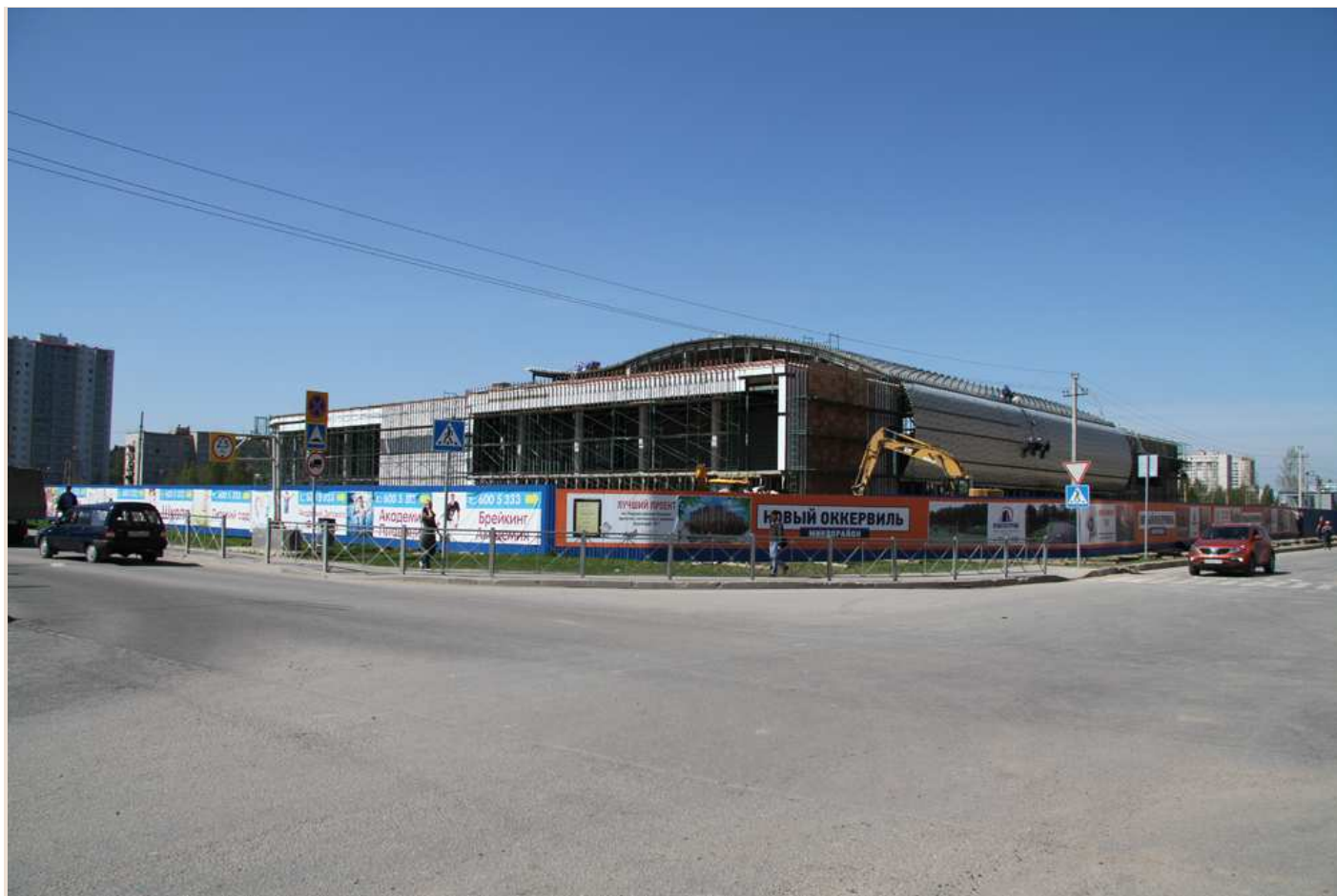
СТРОИТСЯ СПОРТИВНЫЙ КОМПЛЕКС. ФОТО ОТ 15.05.2012
