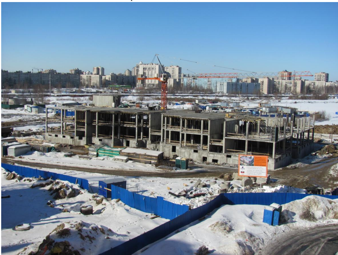
Строительство детского сада
