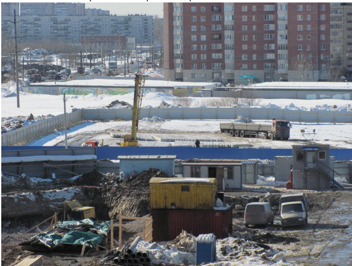
Строительство спортивно-оздоровительного комплекса
