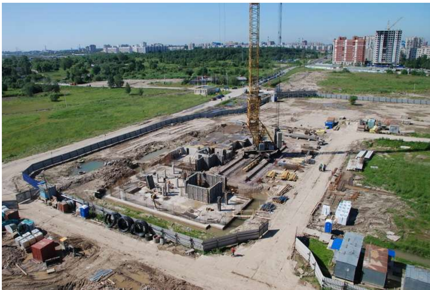
Фотография от 29.06.2010 (II-я оч. строительства)
