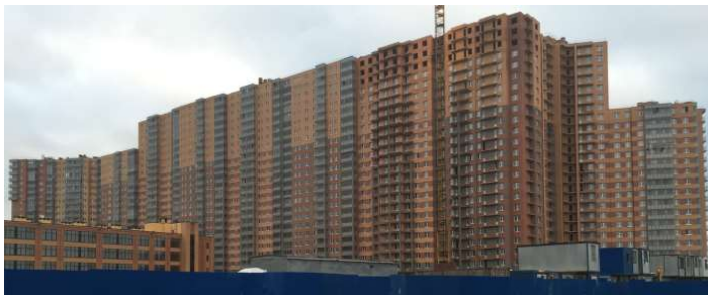
Вид со стороны Областной улицы, секции 6-4, 35-29, 25-19
