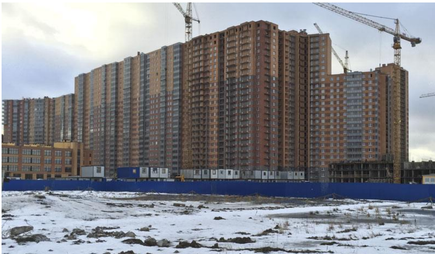
Вид со стороны Областной улицы, секции 6-4, 35-29, 25-19
