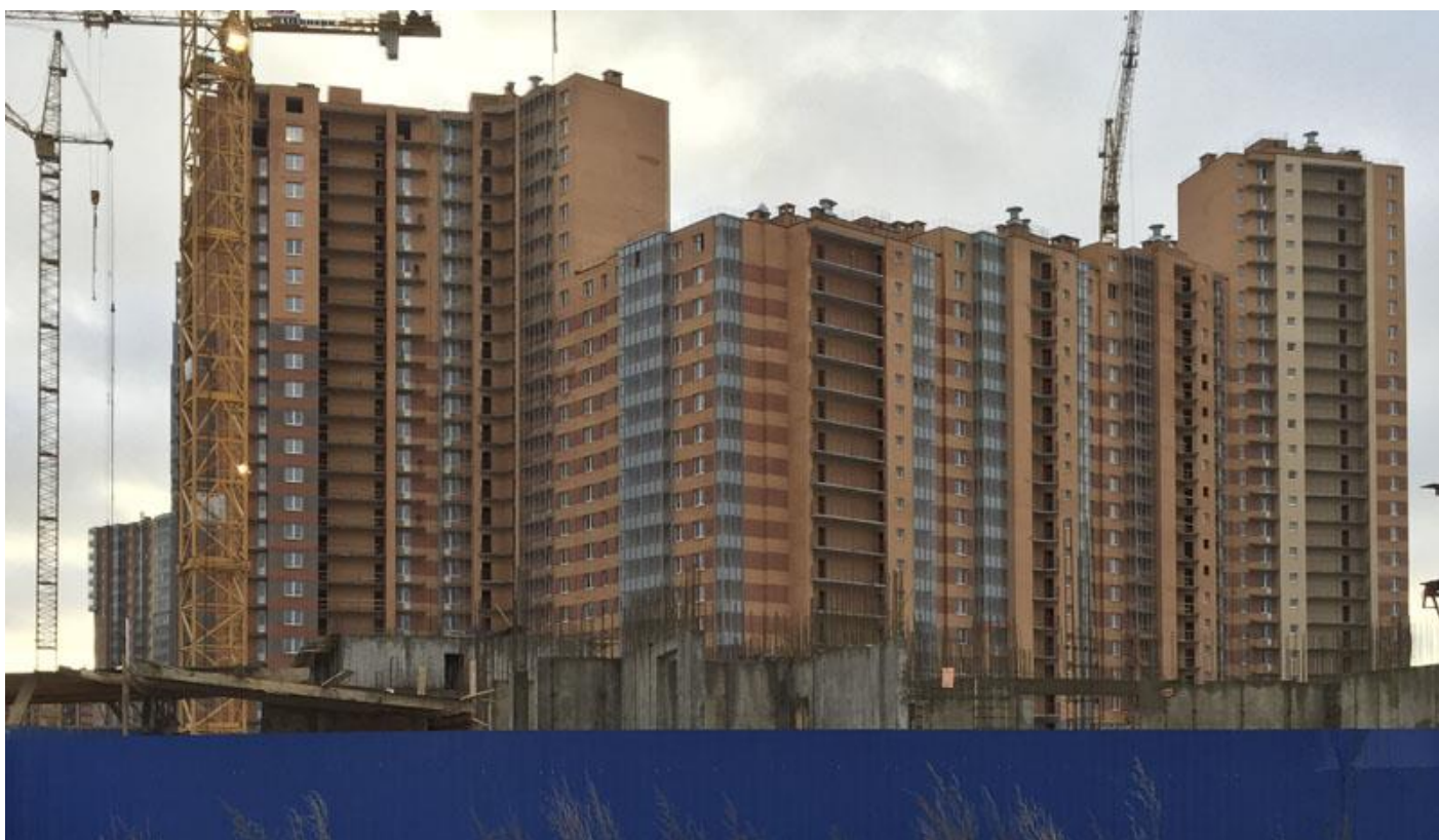
Вид со стороны Областной ул., секции 24-12
