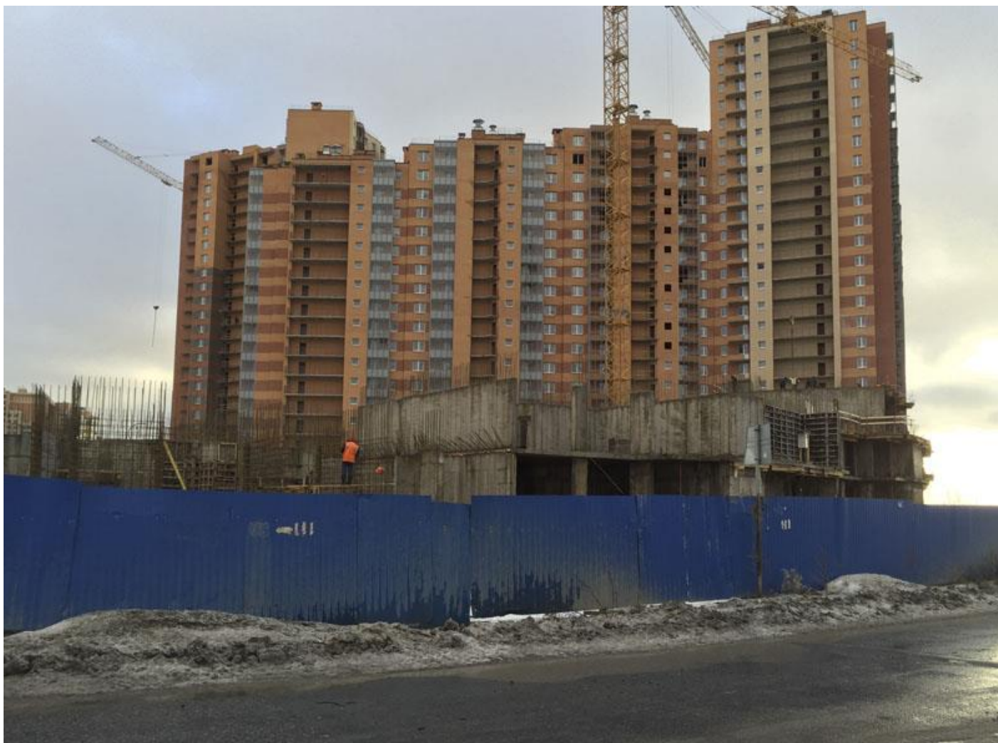
Вид со стороны Областной ул., секции 24-19
